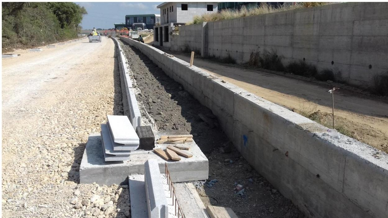
INP 201 – Cordoli marciapiede in Sx, idraulica di piattaforma e misto granulare non legato in corso.
