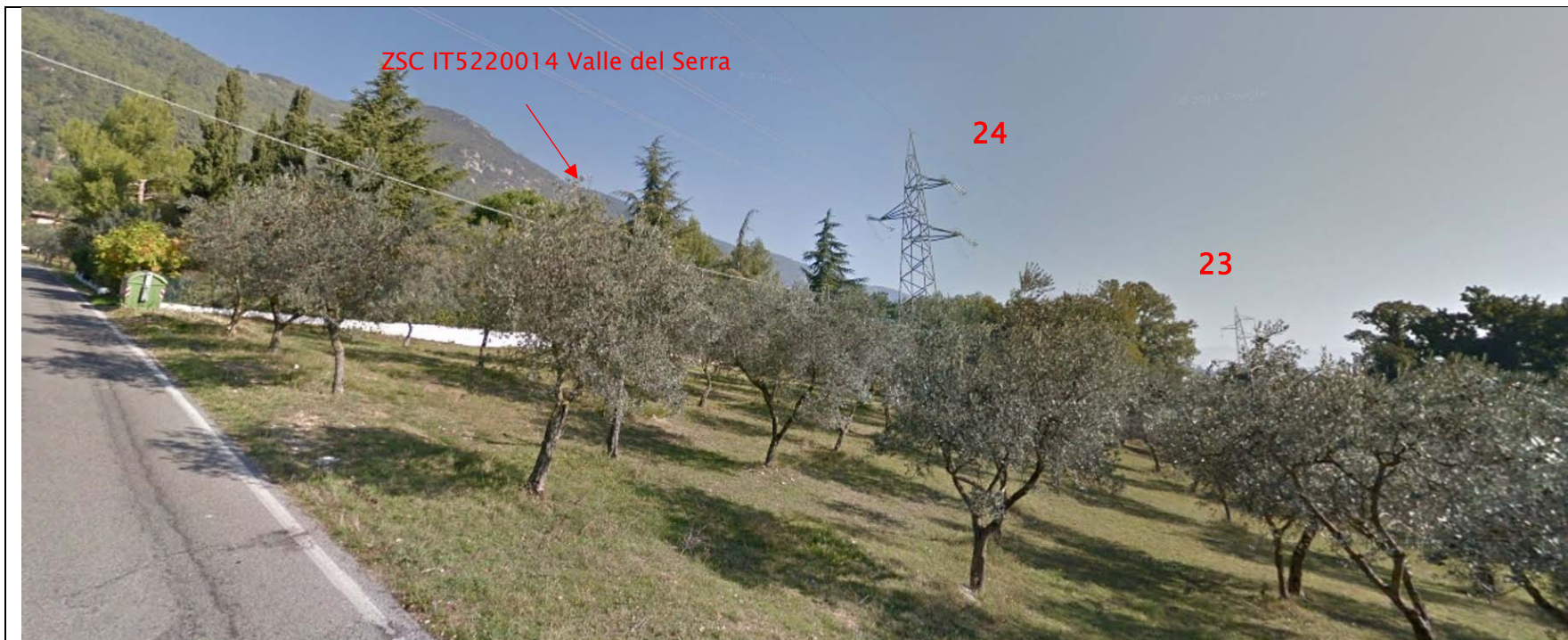
Foto5: TRALICCI 23-24 RISPETTO ZSC IT5220014 Valle del Serra, dall'abitato di strada di Piedimonte
