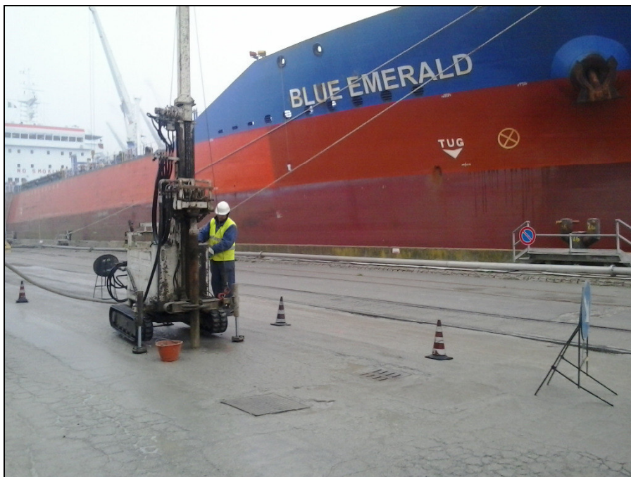
Perforatrice cingolata per esecuzione prefiori
