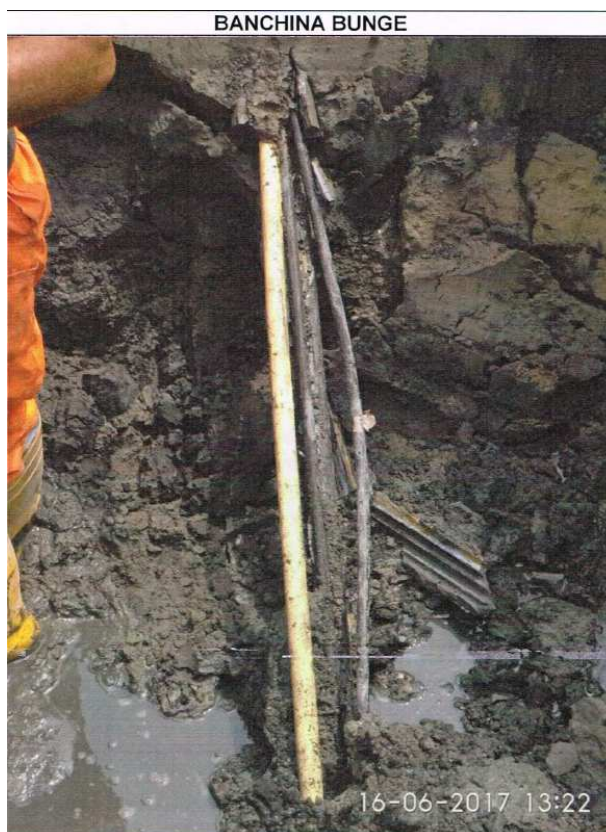
Figura 12 – Fotografia del tirante di ancoraggio a tergo della trave
