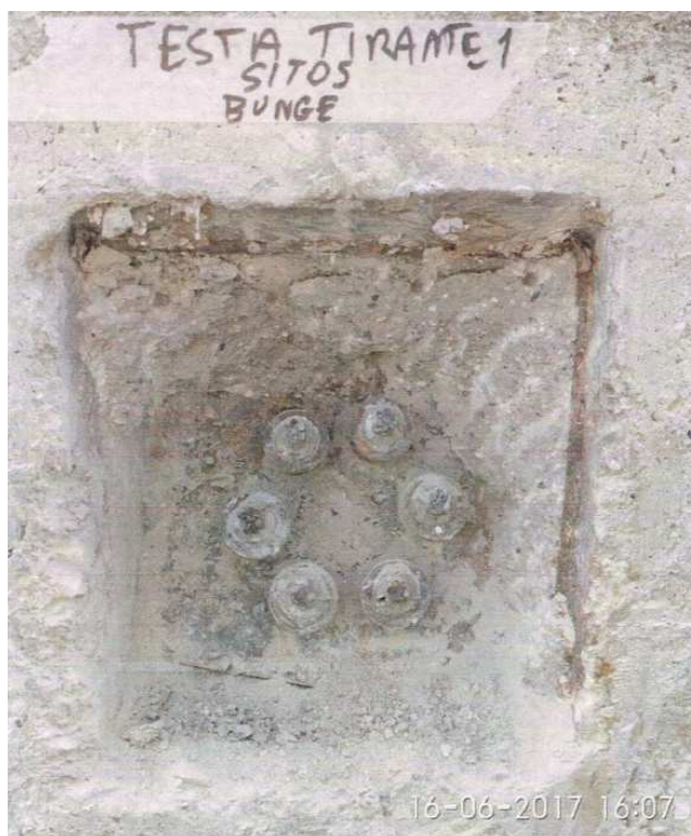
Figura 11 – Fotografia della testata di ancoraggio della banchina BUNGE SUD
