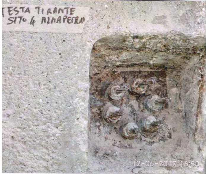
Figura 9 – Fotografia delle testate di ancoraggio della banchina ALMA PETROLI
