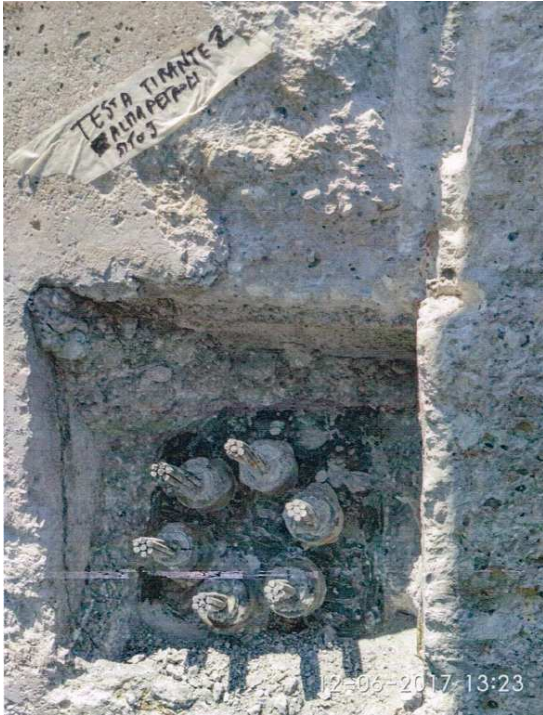
Figura 9 – Fotografia delle testate di ancoraggio della banchina ALMA PETROLI
