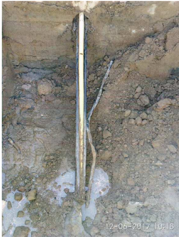
Figura 10 – Fotografia del tirante di ancoraggio a tergo della trave
