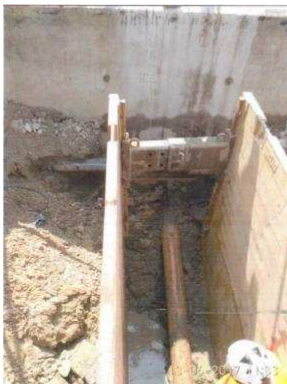
Figura 14 – Fotografia del tirante di ancoraggio a tergo della trave
