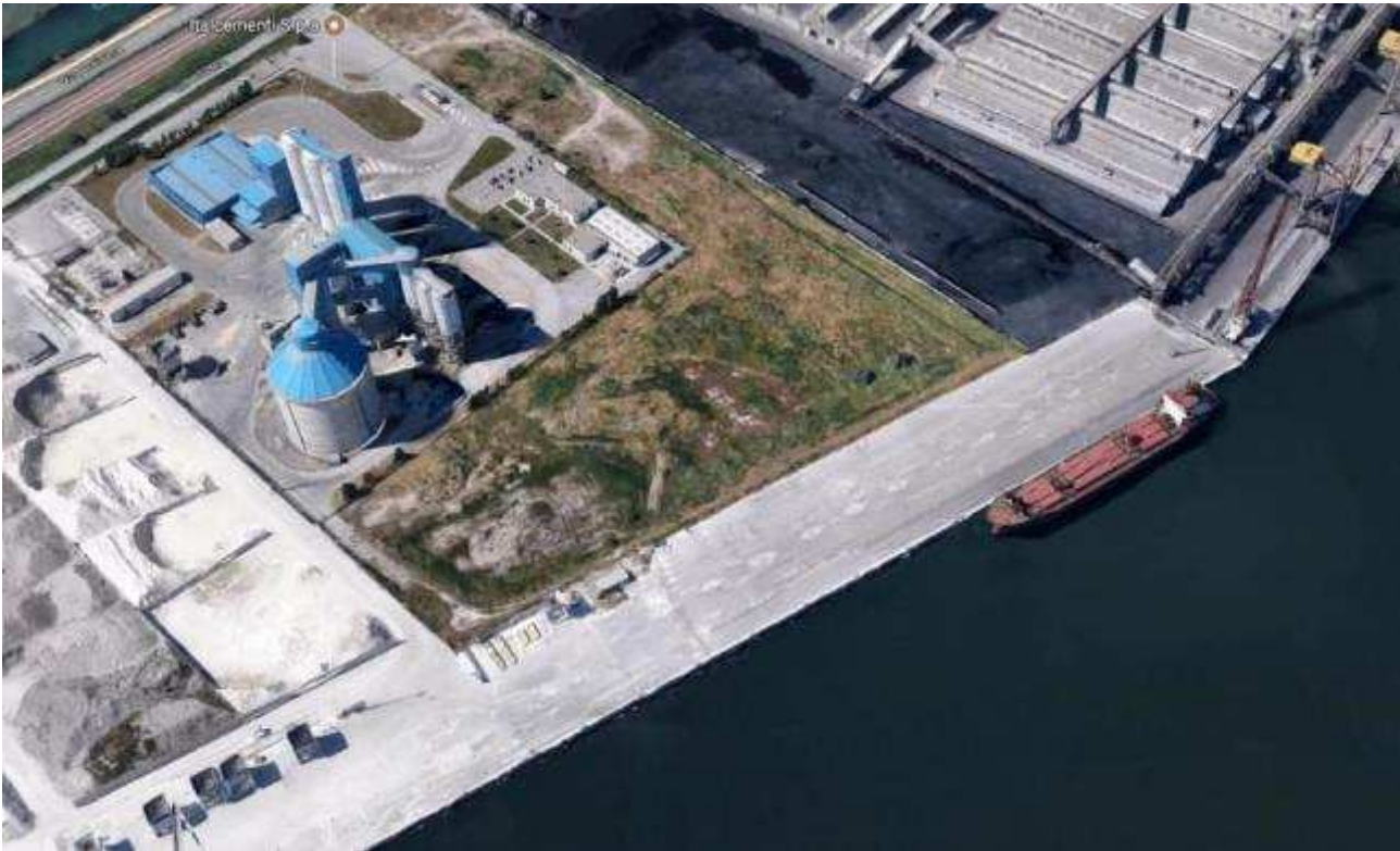
Figura 7 – Vista aerea 3D recente della banchina Trattaroli Nord (da Google maps, 2017)
