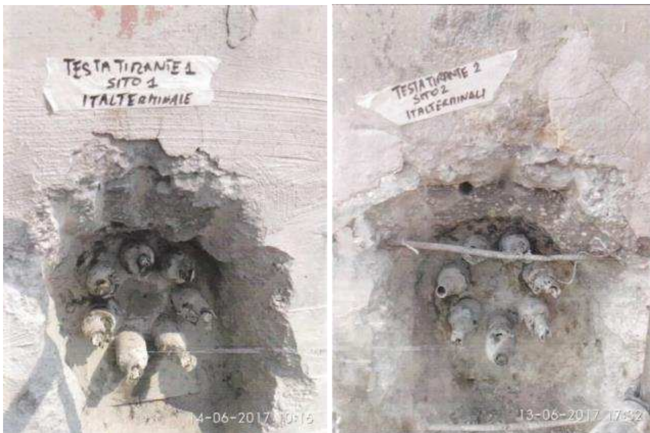
Figura 13 – Fotografia delle testate di ancoraggio della banchina TRATTAROLI NORD
