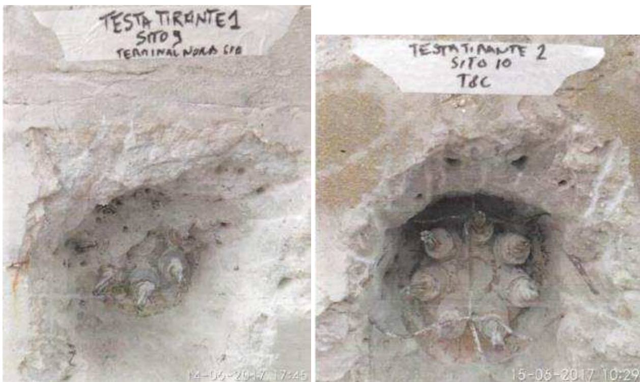
Figura 10 – Fotografia delle testate di ancoraggio della banchina TRATTAROLI SUD
