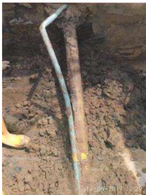
Figura 11 – Fotografia del tirante di ancoraggio a tergo della trave
