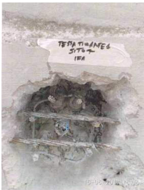
Figura 12 – Fotografia delle testate di ancoraggio della banchina IFA
