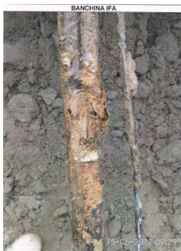
Figura 13 – Fotografia del tirante di ancoraggio a tergo della trave
