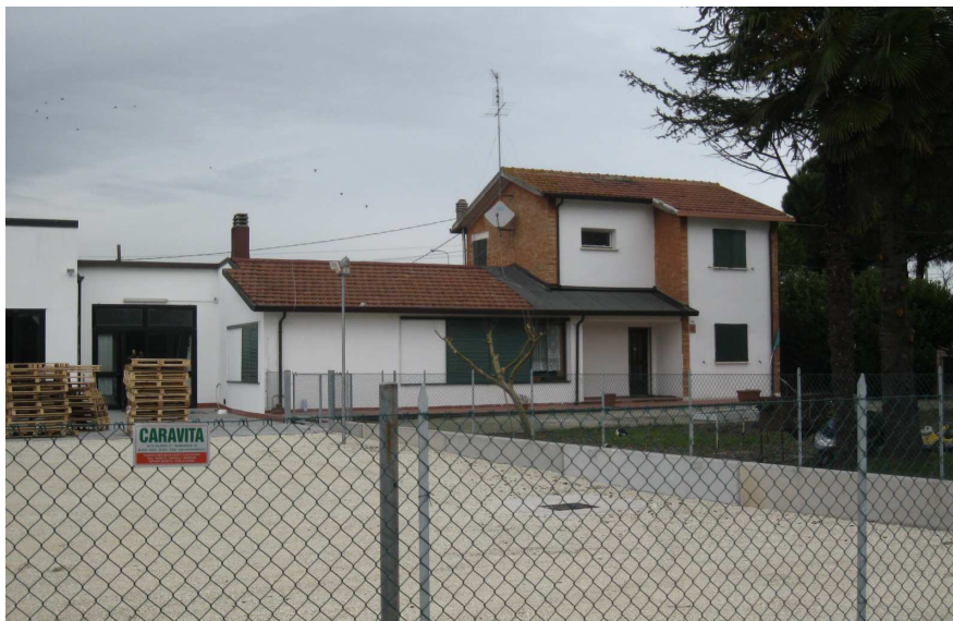
Foto 7: vista di un edificio esistente
