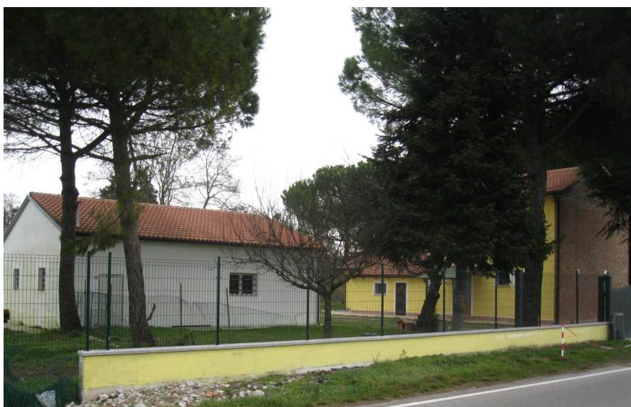
Foto 8: vista di un edificio esistente
