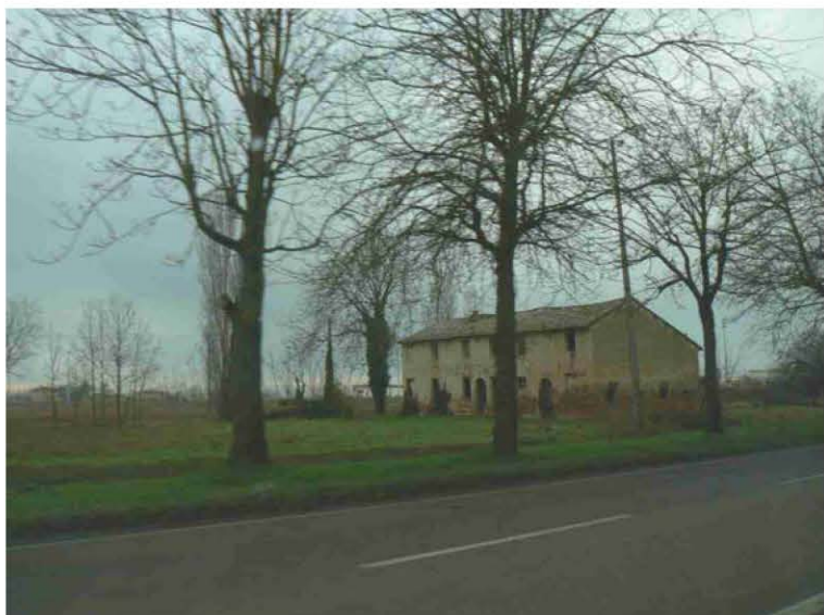
Foto 9: vista da via Baione, edificio esistente
