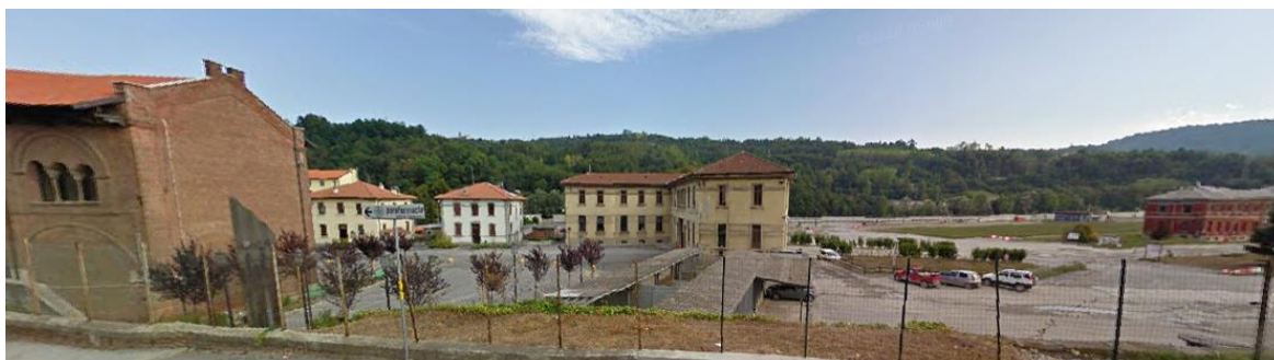
Figura 4-24 Palazzo Rosso sulla sinistra, gli edifici di ingresso all'area Syndial
