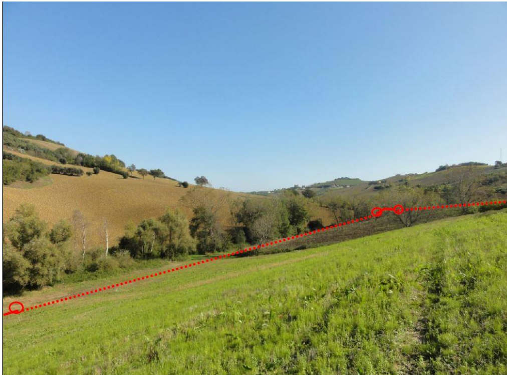
Foto 11 – Area 11. Percorrenza in trenchless del Fosso ValleOscura (linea rossa tratteggiata); sullo sfondo l'imbocco del microtunnel che sottopassa l'area PAI
