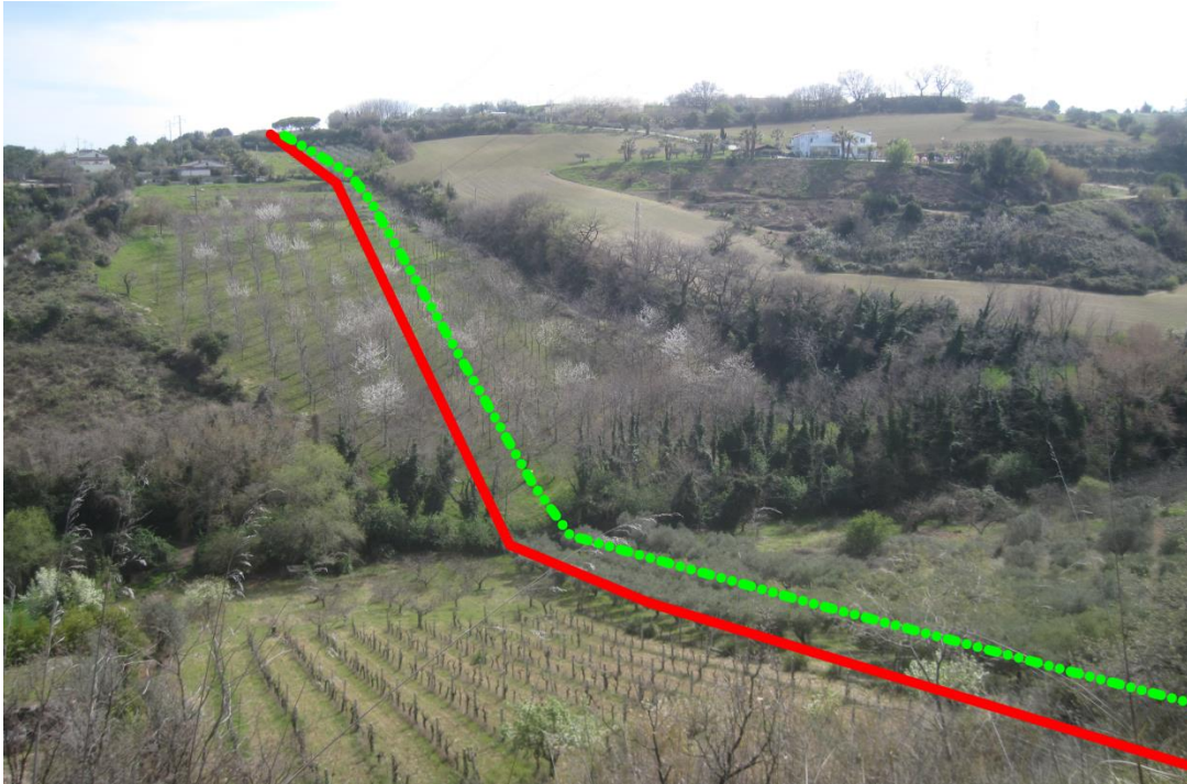
Foto 23 – Area 27. Attraversamento del dissesto sul versante destro della valle del Fosso della Fornace
