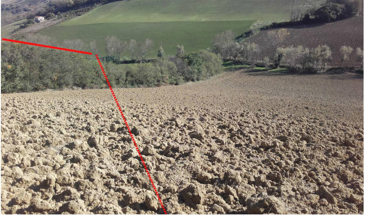
Foto 8 – Area 8. Vista dell’attraversamento del dissesto dalla dorsale di Torre Matteucci. La linea rossa tratteggiata rappresenta la parte attraversata in trenchless
