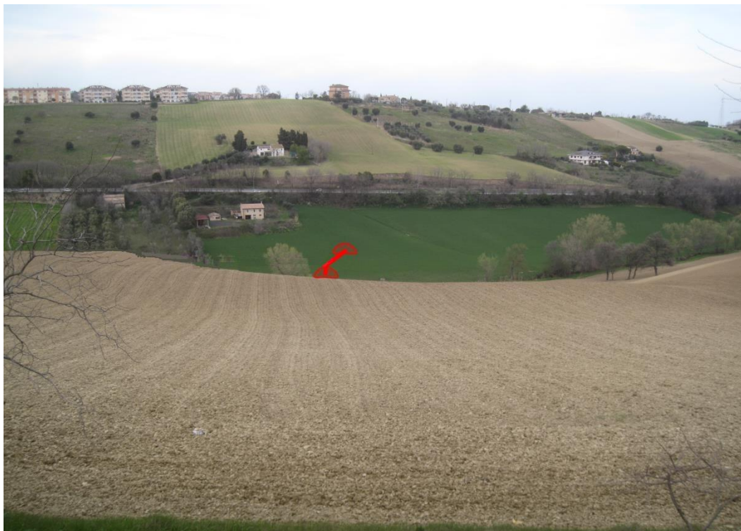
Foto 12 – Area 12. Imbocco del microtunnel che sottopassa l'area PAI nel fondovalle del rio Petronilla
