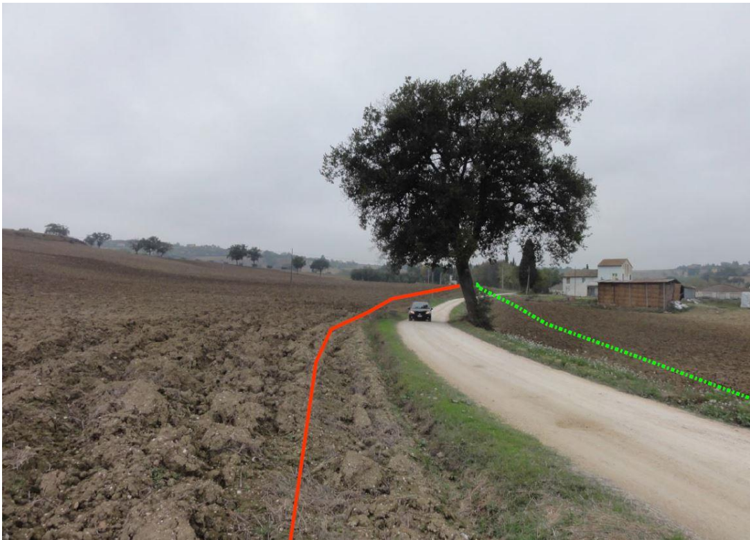
Foto 3 – Area 3. Attraversamento al piede dell'area PAI
