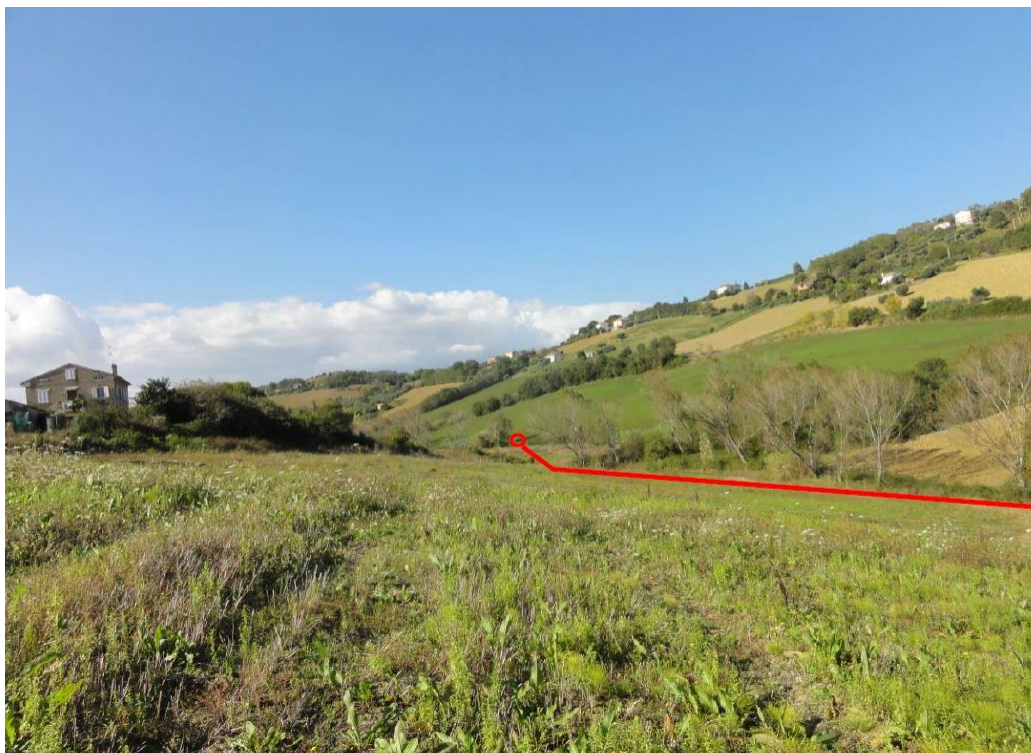
Foto 10 – Area 10. Uscita del microtunnel che sottopassa l'area PAI e percorrenza lungo il fondovalle del Fosso Valle Oscura
