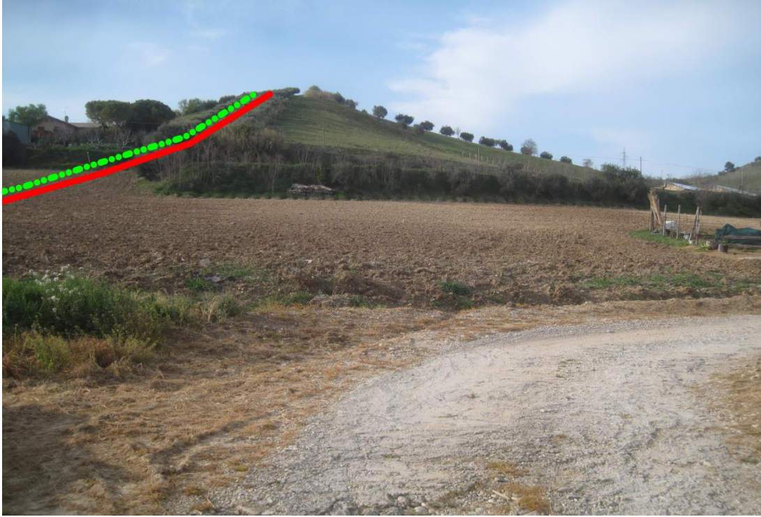
Foto 25 - Area 29. Vista da Sud dell'attraversamento del dissesto
