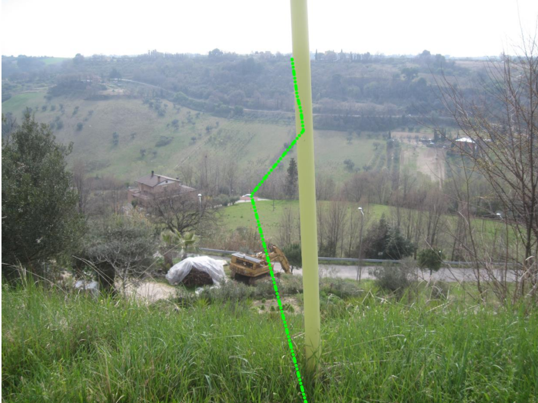
Foto 42– Area 58. Vista del dissesto da Campofilone
