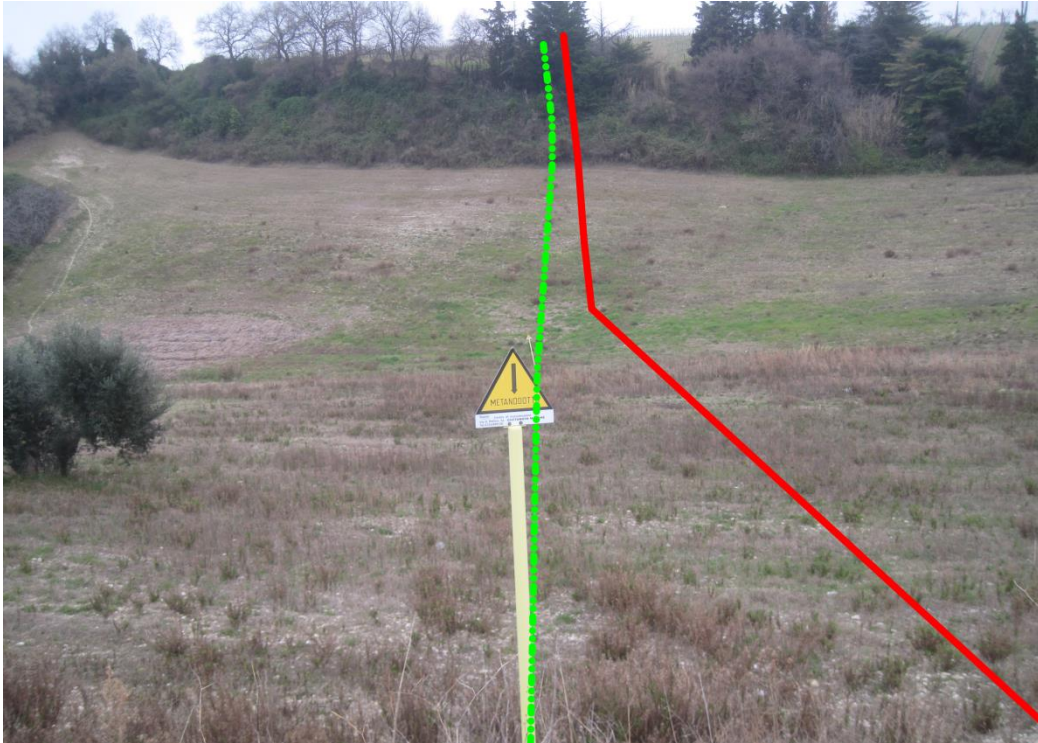
Foto 22 – Area 26. Vista da Nord del versante destro della valletta in cui è situato il dissesto.
