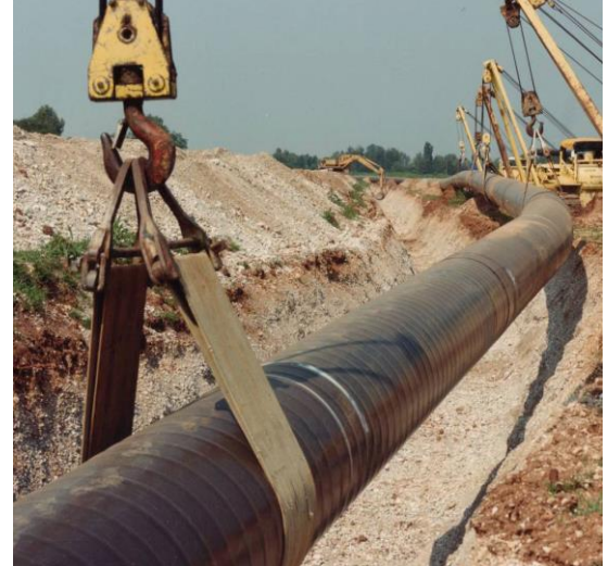
Figura 5. Posa della condotta
