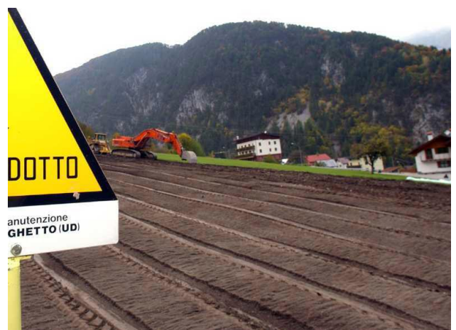
Figura 7. Ridistribuzione dello strato superficiale di suolo (topsoil)
