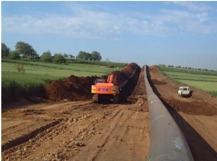
Figura 4. Scavo in trincea
