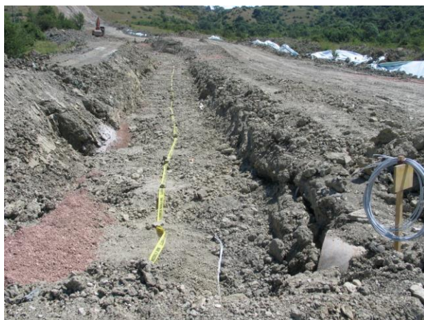
Figura 6. Rinterro della condotta
