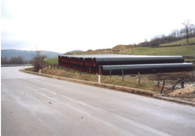
Figura 2. Piazzola di accatastamento tubazioni
