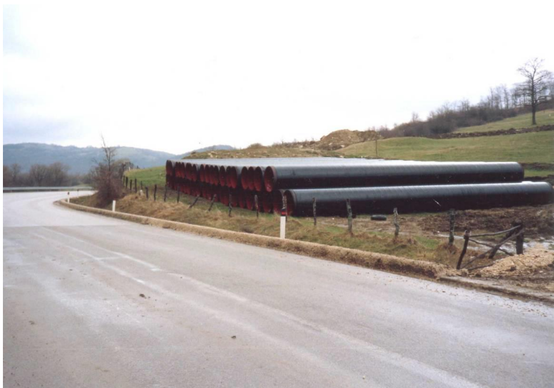
Foto 3.2/B: Esempio di piazzola di accatastamento tubazioni
