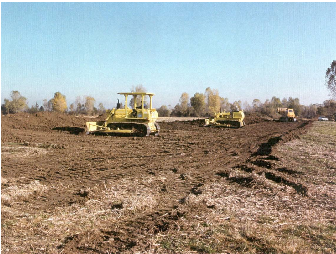
Foto 3.2/C: Esempio di apertura dell'area di passaggio
