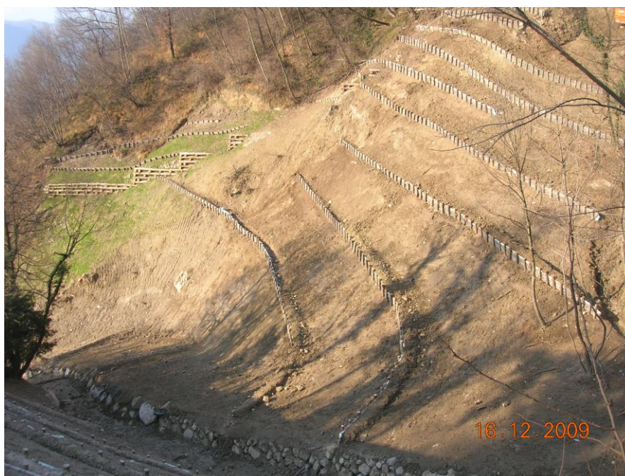
Fig. 3.2/K: Esempio di ripristino morfologico e consolidamento di un versante con opere di ingegneria naturalistica (palizzate e palificate).
