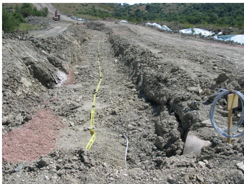
Foto 3.2/H: Esempio di rinterro della condotta.
