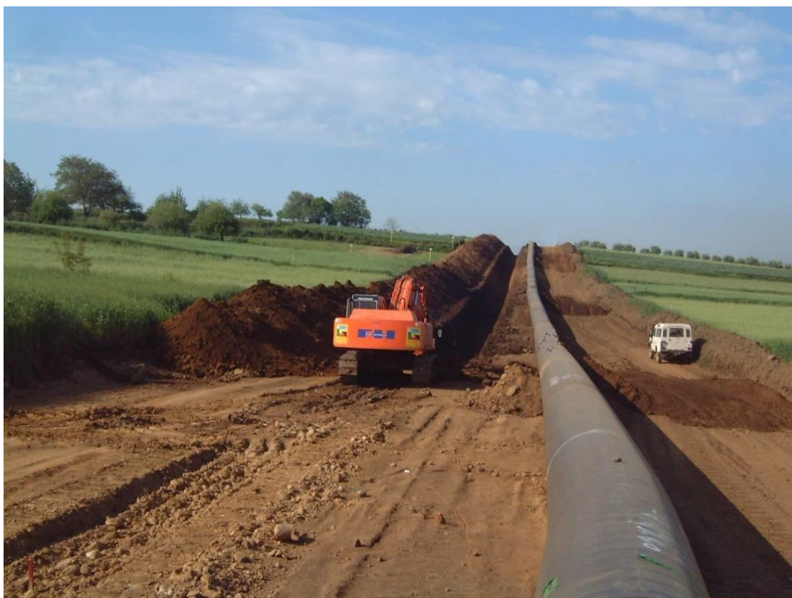
Foto 3.2/F: Esempio di scavo in trincea
