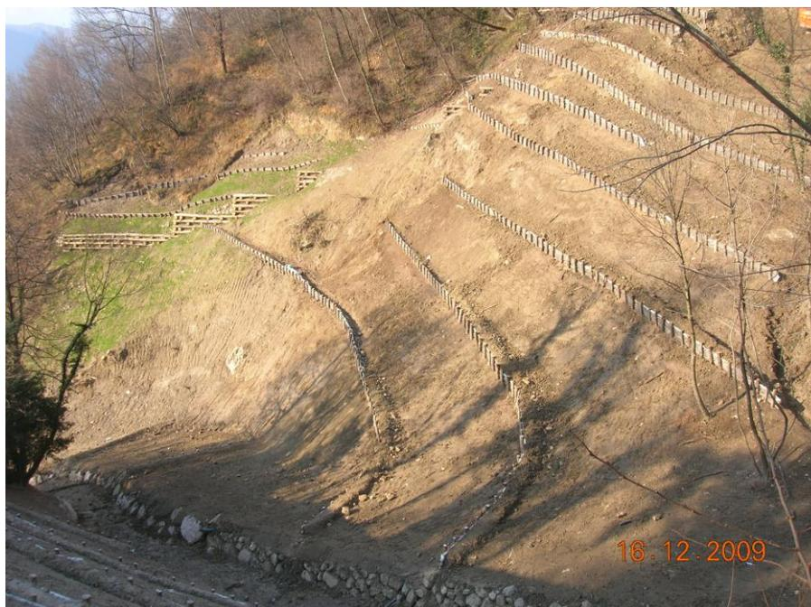
**Foto 2.K:** Esempio di ripristino morfologico e consolidamento di un versante con opere di ingegneria naturalistica (palizzate e palificate).
