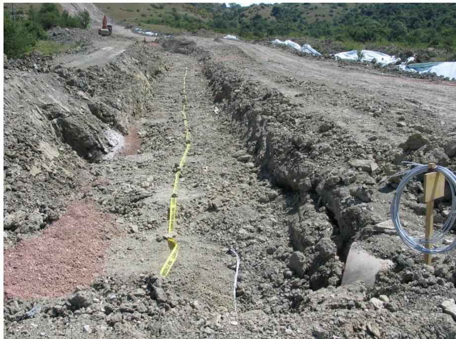
**Foto 2.H:** Esempio di rinterro della condotta.
