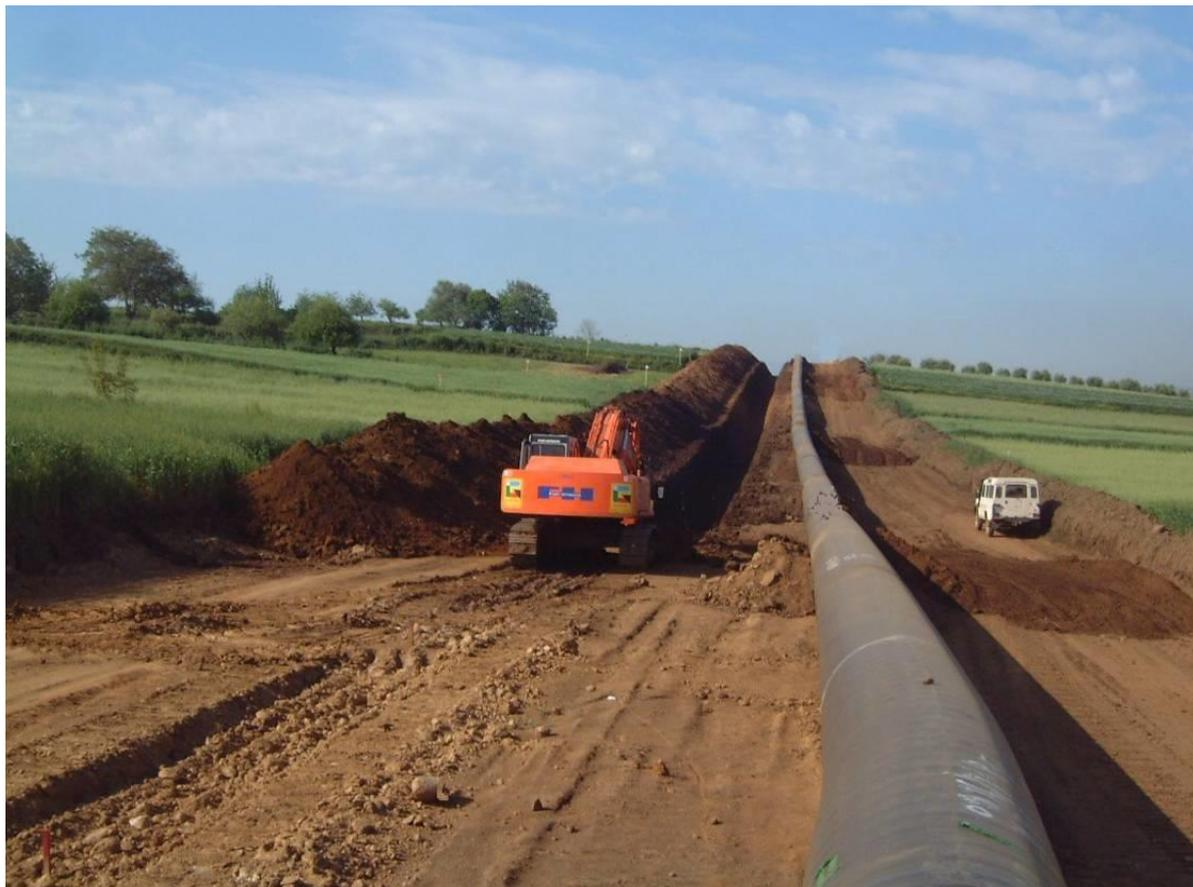
**Foto 2.F:** Esempio di scavo in trincea
