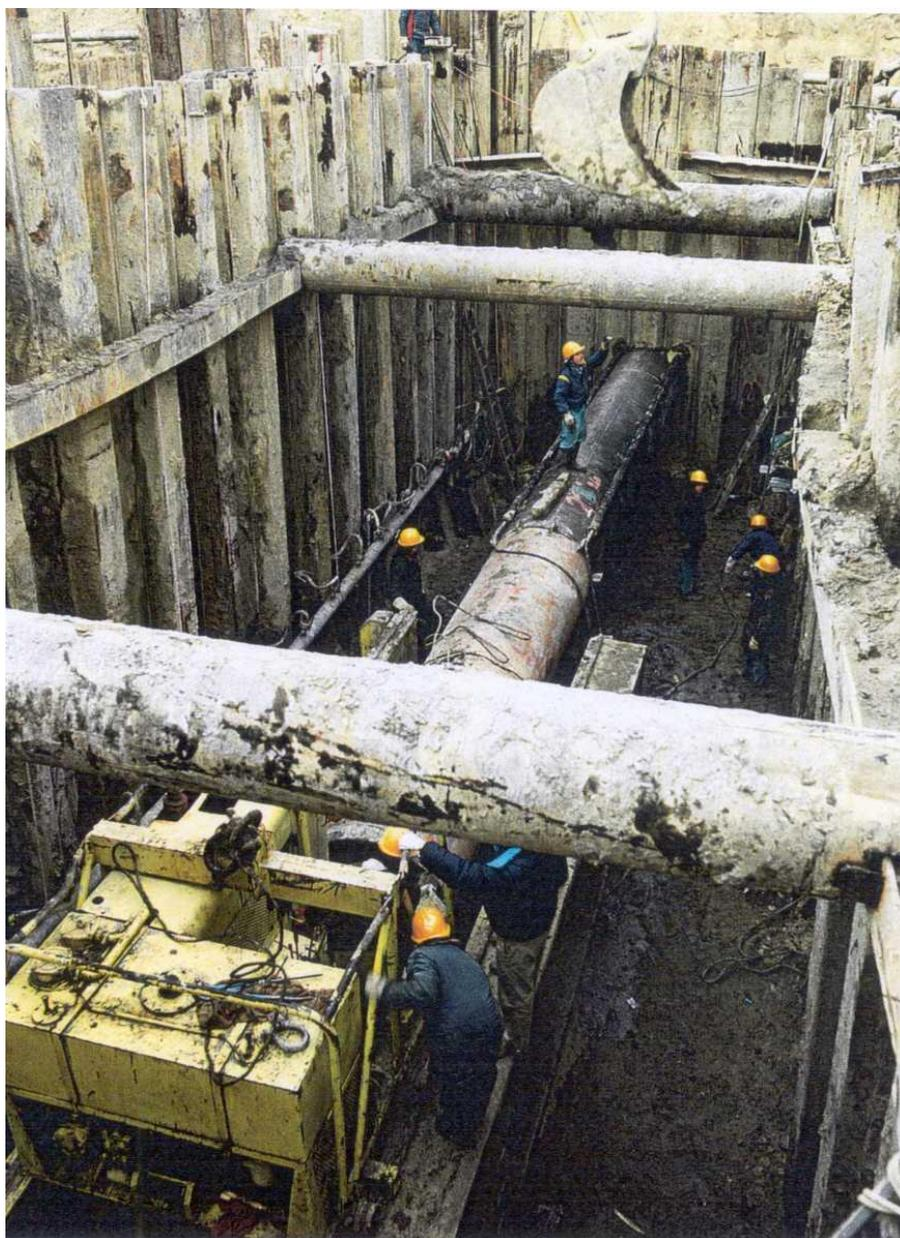
**Foto 4.1/L: Trivellazione con spingitubo**
