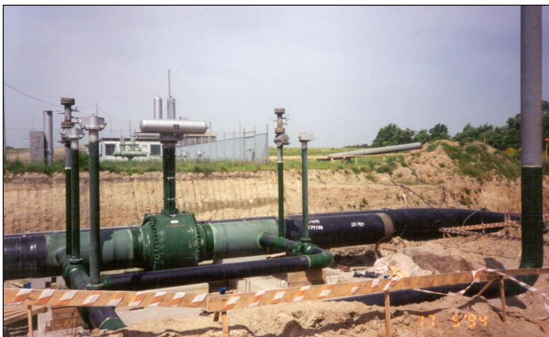
**Foto 4.1/N: Esempio di punto di intercettazione di linea (PIL)**
