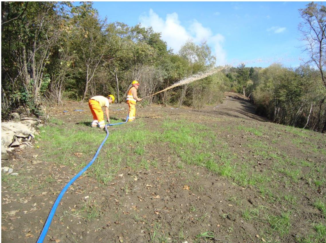
**Foto 7.2.3/A – Inerbimento mediante semina idraulica (idrosemina). Contemporaneamente al miscuglio di semi vengono distribuiti anche fertilizzanti, collanti naturali e coltre protettiva.**
