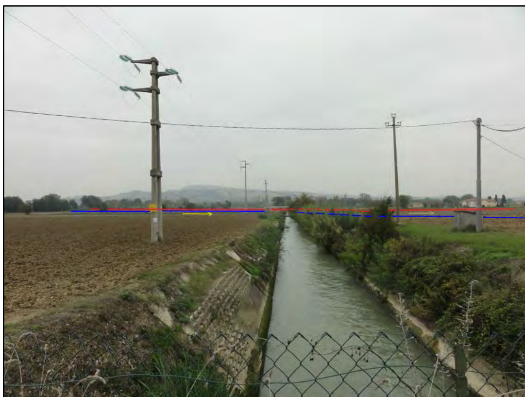
Foto 2: Attraversamento del canale in prossimità della Centrale Green Power di Montelupone, in parallelo all'attraversamento aereo da dismettere.
