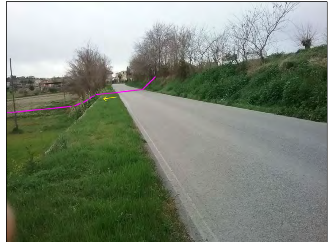
Foto 67: Rif. Comune di S. Elpidio a Mare DN 150 (6"), DP 75 bar. Attraversamento della S.P. 154 (Fonte di Mare).
