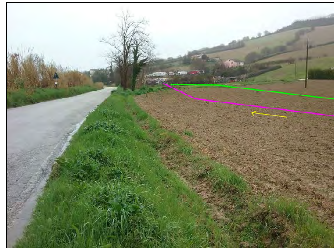
Foto 75: Rif. Coll. Pozzi ELF S. Giorgio a Mare DN 250 (10''), DP 75 bar. Percorrenza in prossimità della sponda destra del Fiume Ete Vivo all'uscita della TOC F.Ete Vivo.
