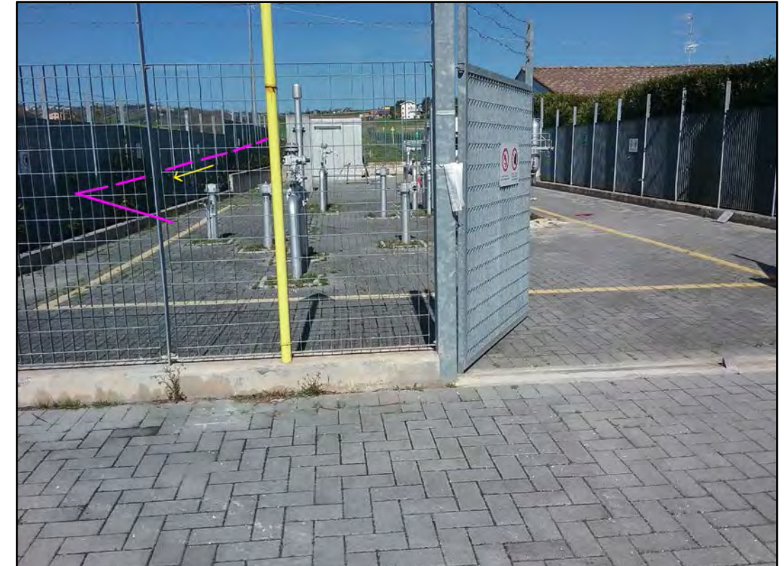
Foto 63: Nuovo Coll. SIG Montecosaro DN 100 (4\"), DP 75 bar. Tratto finale con arrivo nell'area dell'impianto esistente (Borgo Stazione di Montecosaro).
