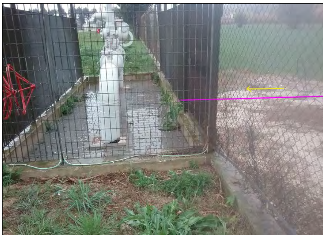
Foto 74: Rif. Coll. Pozzi ELF S. Giorgio a Mare DN 250 (10''), DP 75 bar. Tratto finale con arrivo nell'area dell'impianto esistente (Santa Maria a Mare).
