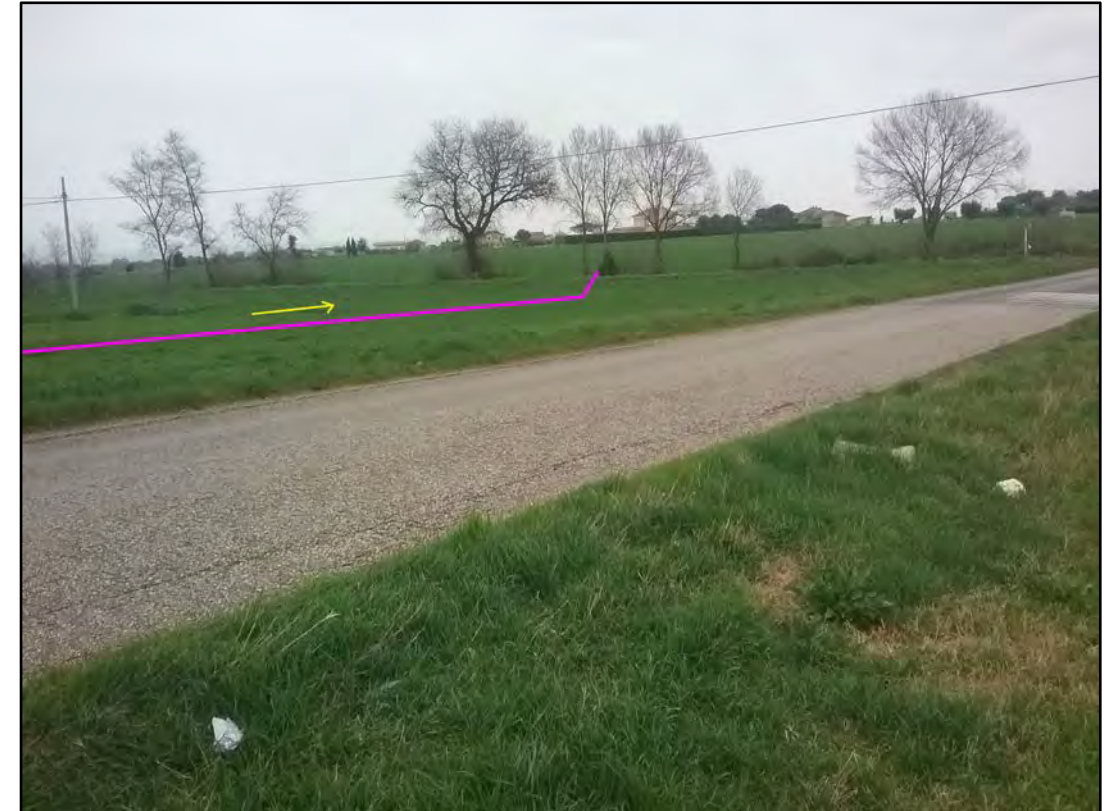
Foto 71: Coll. Comune di Porto Sant' Elpidio DN 150 (6"), DP 75 bar. Percorrenza in direzione dell'allacciamento esistente 4360095 (per Porto s.Elpidio) nella piana della Valle del Tribbio.
