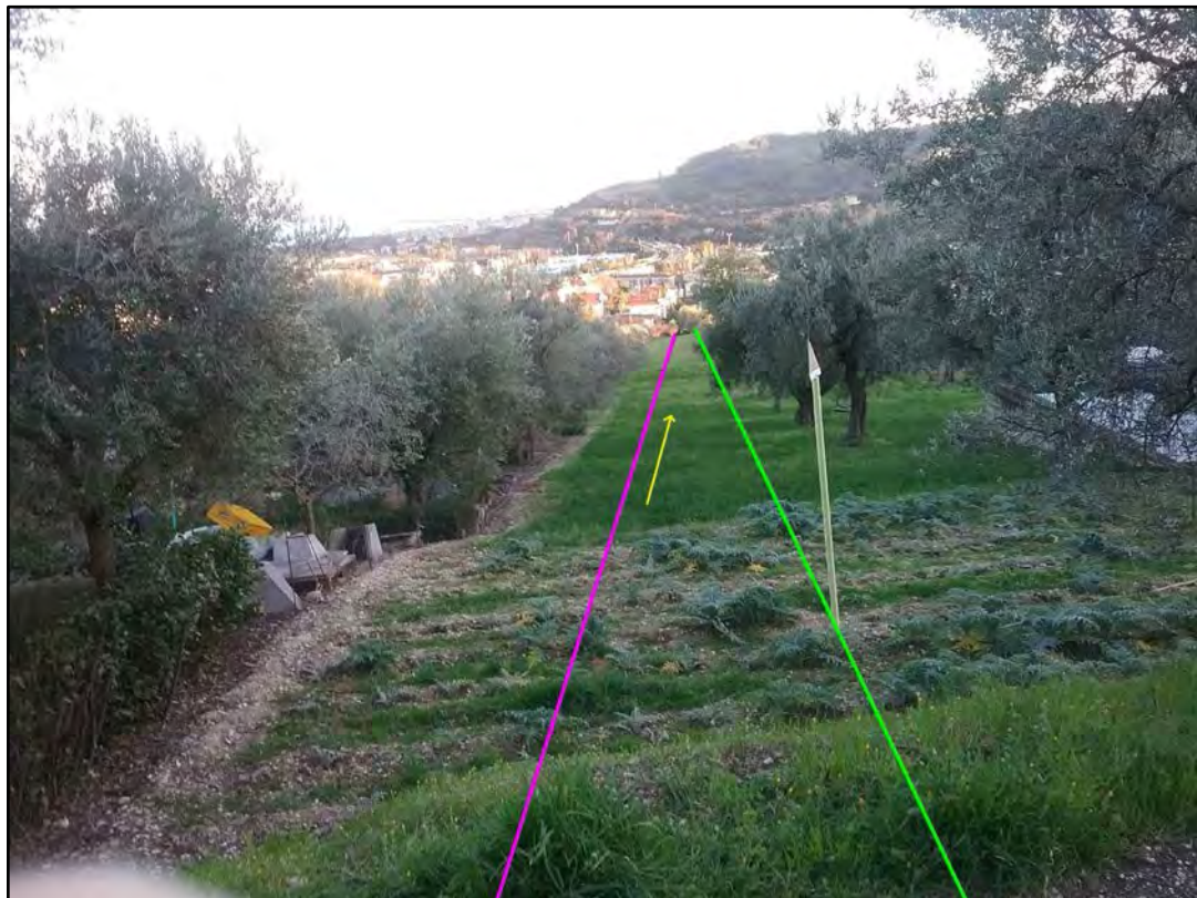
Foto 78: Rif. Comune di Grotammare DN 100 (4"), DP 75 bar. Percorrenza in parallelo con la linea da dismettere.
