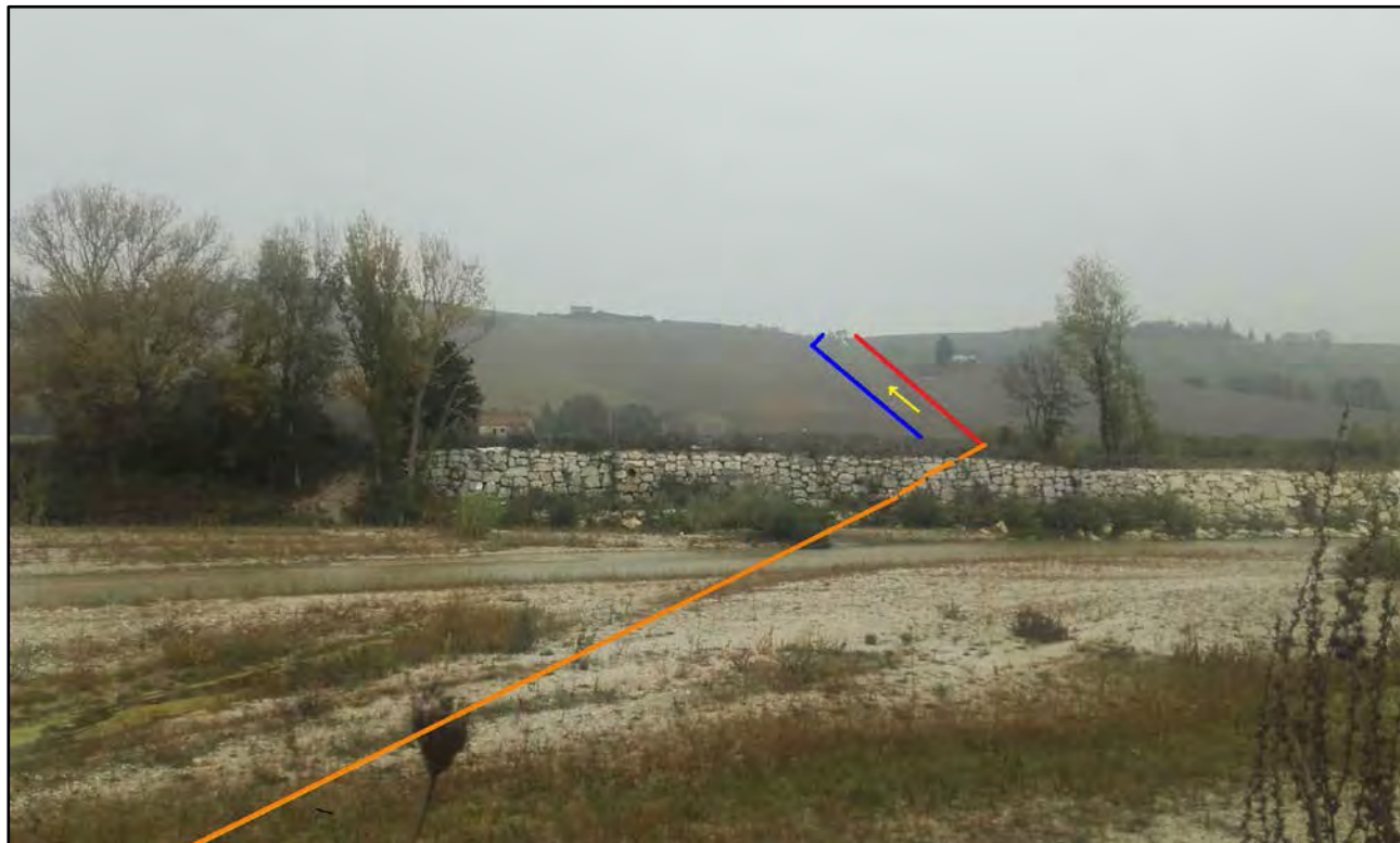
Foto 34: Attraversamento del Fiume Tenna (in arancio il tratto di variante riutilizzato) e tratto iniziale della TOC Torre Matteucci.
