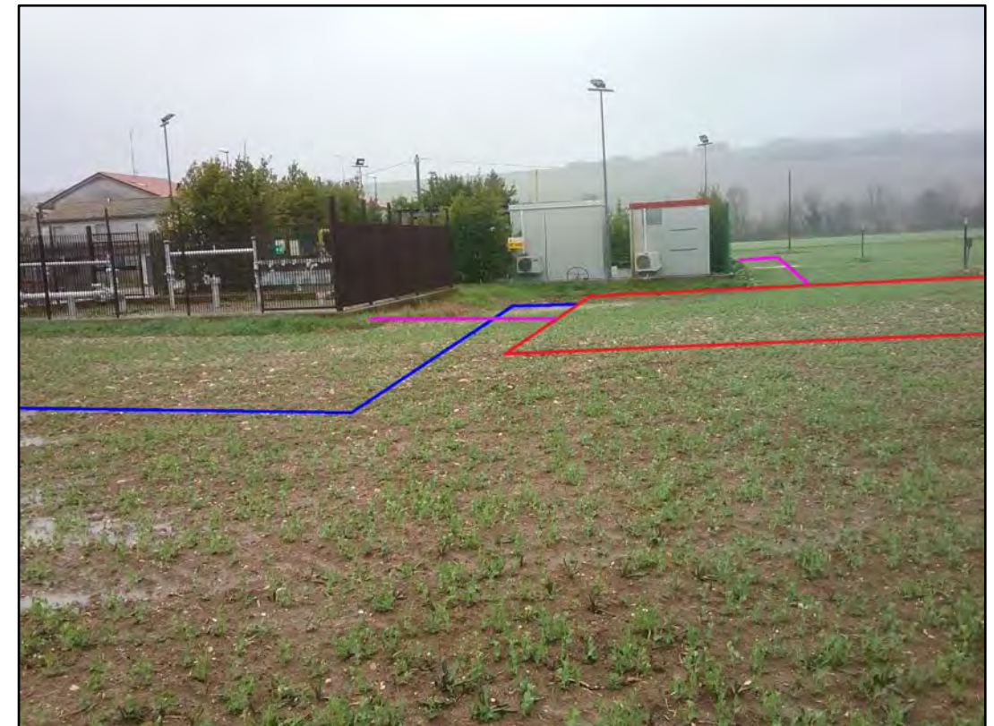
Foto 72: Coll. Pot. Deriv. per Montegiorgio DN 300 (12"), DP 75 bar. Area in cui si ha il collegamento con l'allacciamento 4100913 (per Montegiorgio) e con l'allacciamento a SGI.
