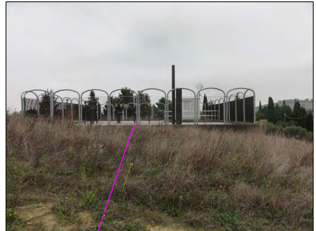
Foto 60: Coll. Comune di Morrovalle DN 100 (4''), DP 75 bar. Tratto finale con arrivo nell'area dell'impianto esistente.
