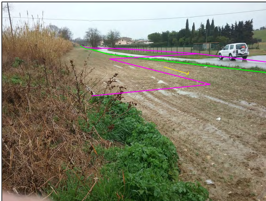
Foto 73: Coll. CoMeTra (Fermo) DN 100 (4''), DP 75 bar. Percorrenza in prossimità dell'intersezione con il tratto d'allacciamento esistente da mantenere (in viola il rifacimento 4101405 ai Pozzi ELF).
