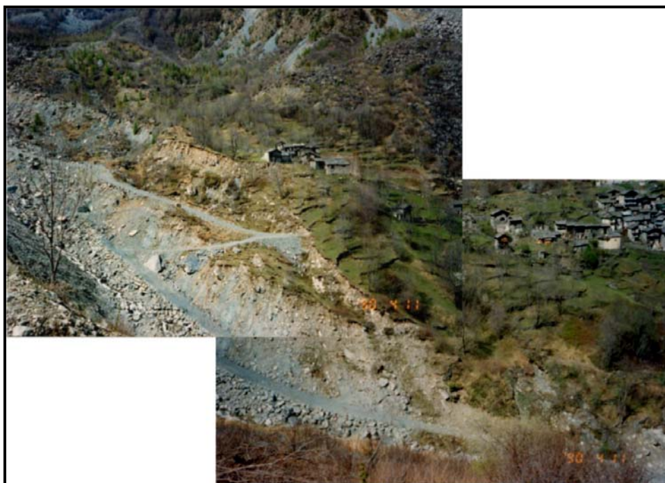
Figura 1 – Versante sotto Braccia prima degli interventi. Si notano i terrazzamenti residui asportati successivamente
