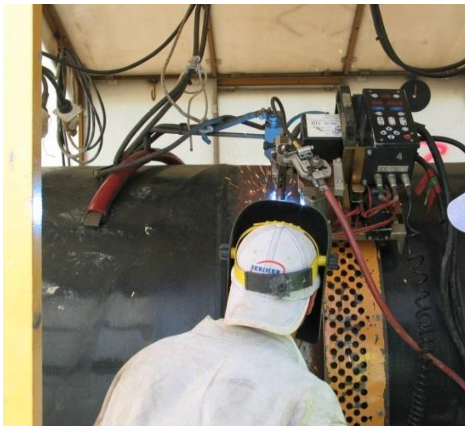
Foto 5.1/E: Esempio di saldatura di linea
