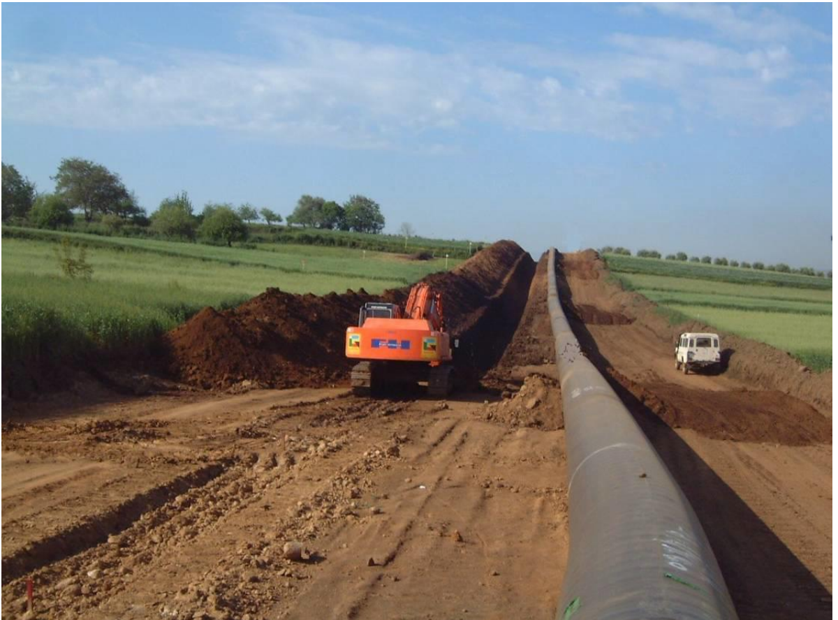
Foto 5.1/F: Esempio di scavo in trincea
