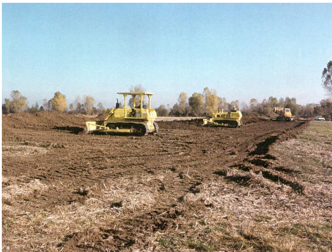
Foto 5.1/C: Esempio di apertura dell'area di passaggio
