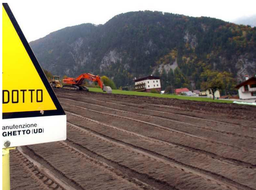
Foto 5.1/J: Esempio di redistribuzione dello strato superficiale di suolo (topsoil)
