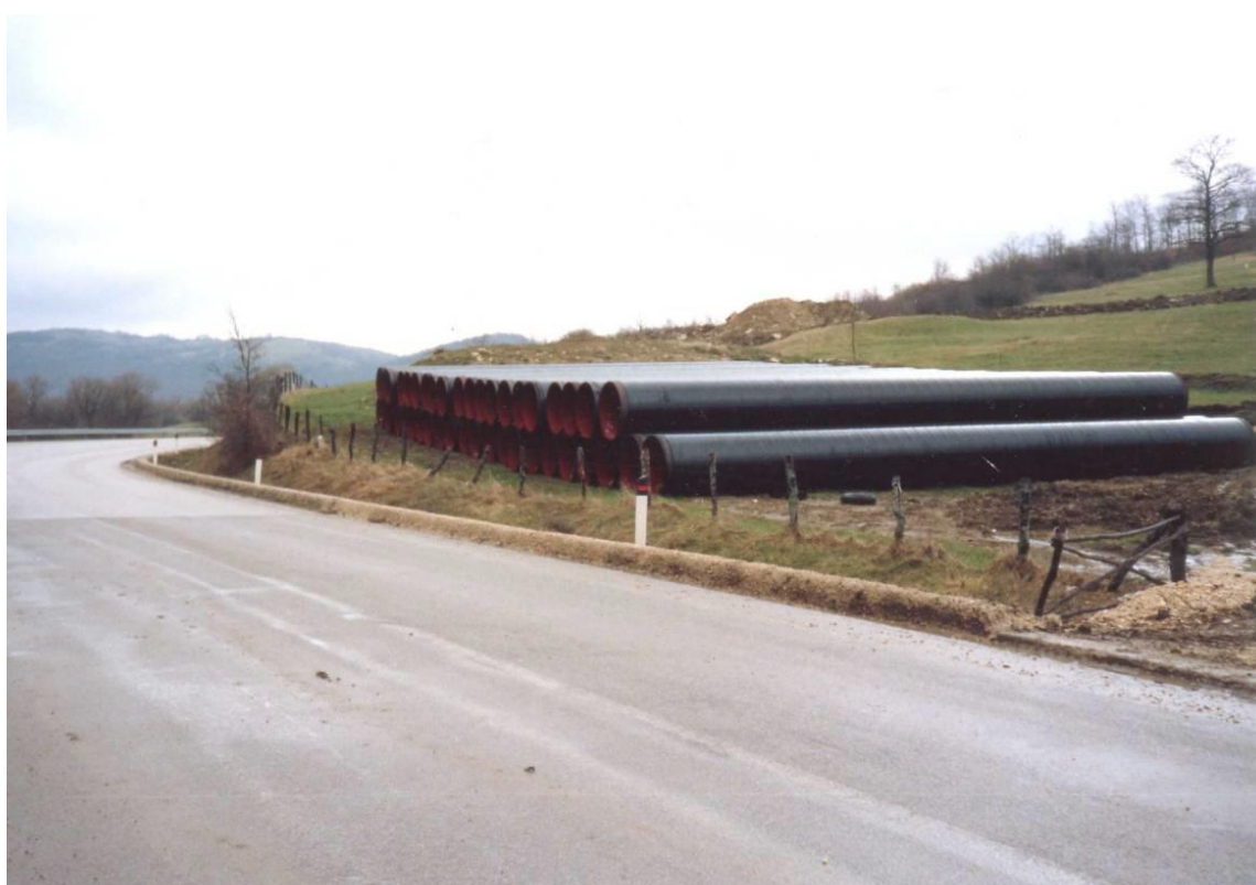
Foto 5.1/B: Esempio di piazzola di accatastamento tubazioni
