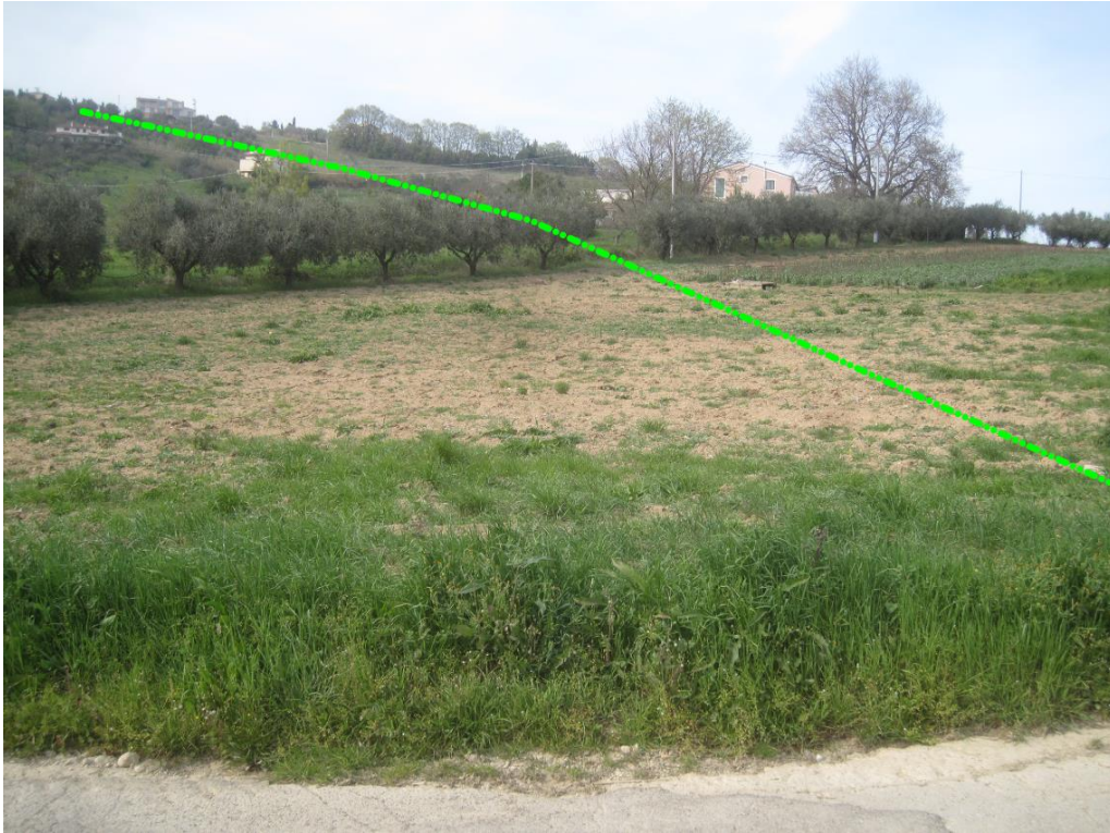
Foto 35 – Area 55. Vista del piede del dissesto
