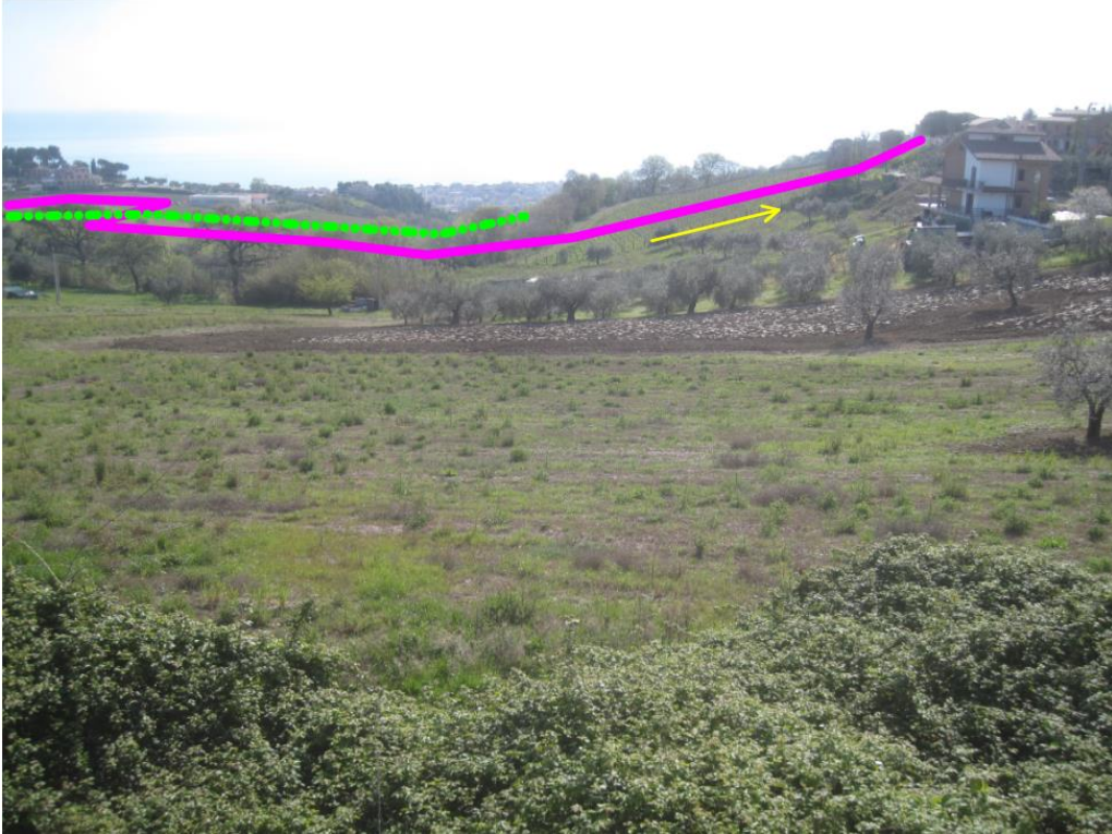
Foto 25 – Area 39. Panoramica del dissesto da Sud
