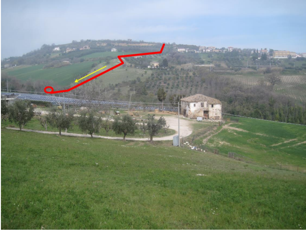
Foto 2 – Area 5 e imbocco del microtunnel nel fondovalle del fosso Giardino.
