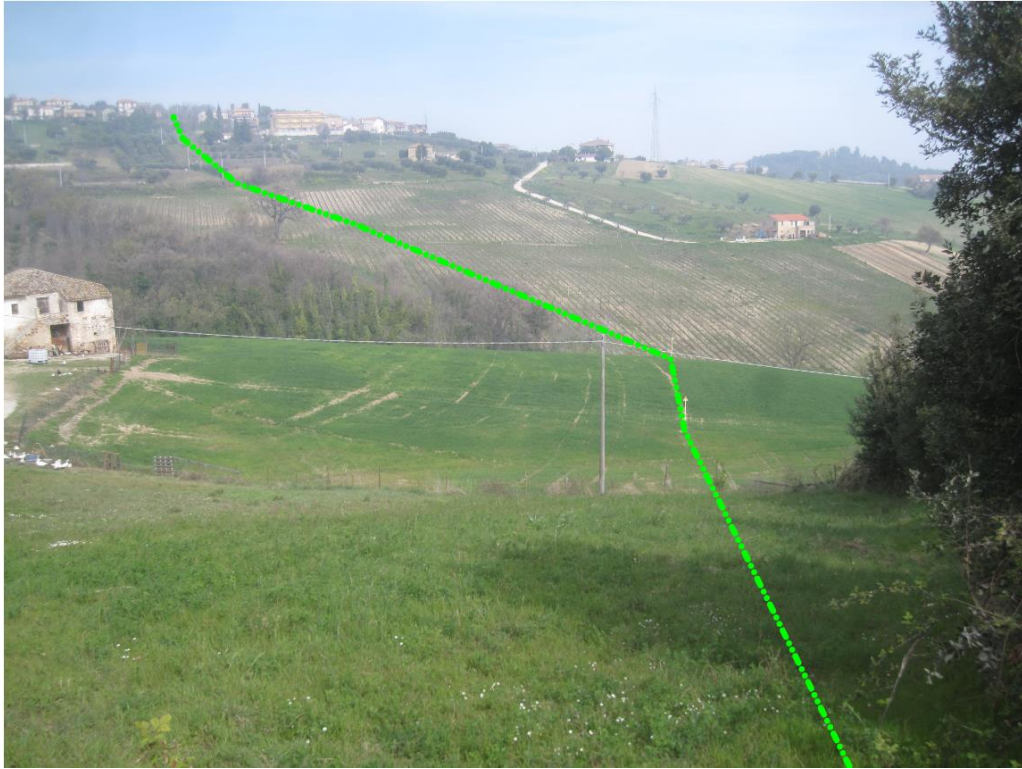
Foto 29 – Area 48. Vista del dissesto dal versante opposto della valle del Fosso Giardino
