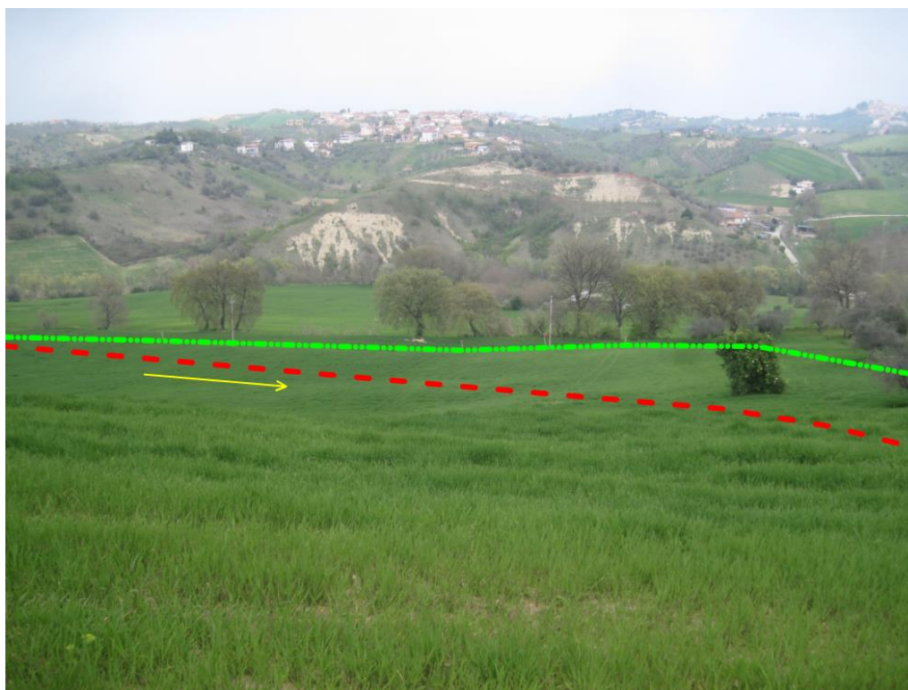
Foto 17 - Area 31 (P3). Vista del tracciato in dismissione dalla strada provinciale
