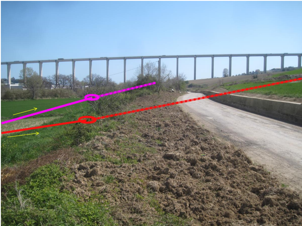
Foto 3 – Imbocchi delle trenchless sulla linea principale (in rosso) e della linea di collegamento (in viola) che attraversano il versante in cui sono situate le aree 9 e 10
