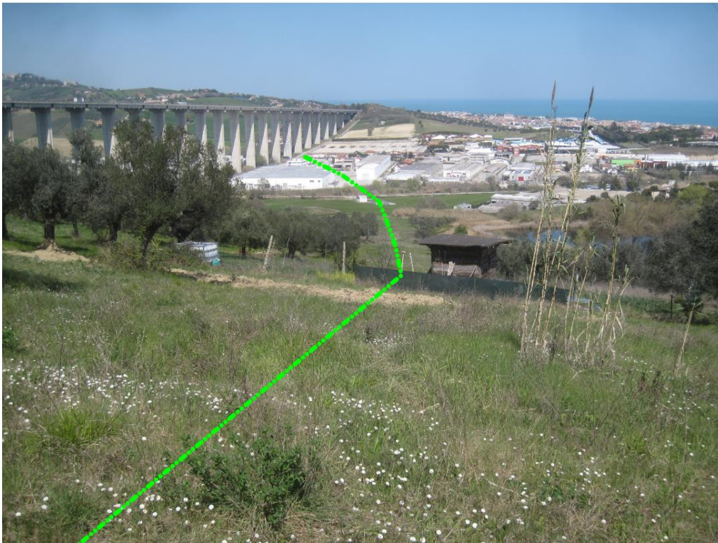
Foto 31 – Area 50. Panoramica del dissesto da monte
