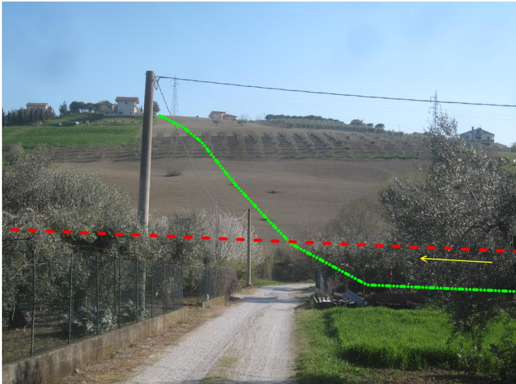
Foto 10 - Area 19 (P3). Vista dal fondovalle del Fosso di Casoli. E' rappresentata la traccia del microtunnel
