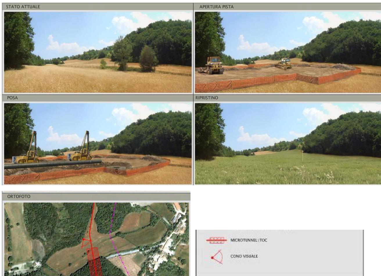
**Figura 8. Simulazione di lavori tipici all'imbocco di un microtunnel (trenchless)**
