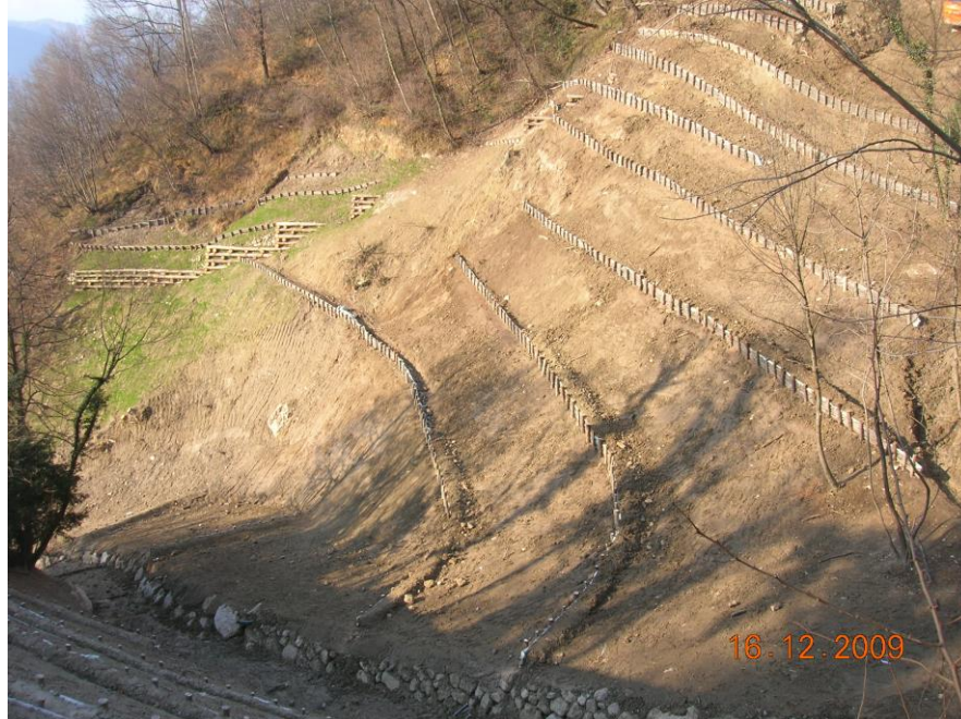
Fig. 3.2/J: Esempio di ripristino morfologico e consolidamento di un versante con opere di ingegneria naturalistica (palizzate e palificate).
