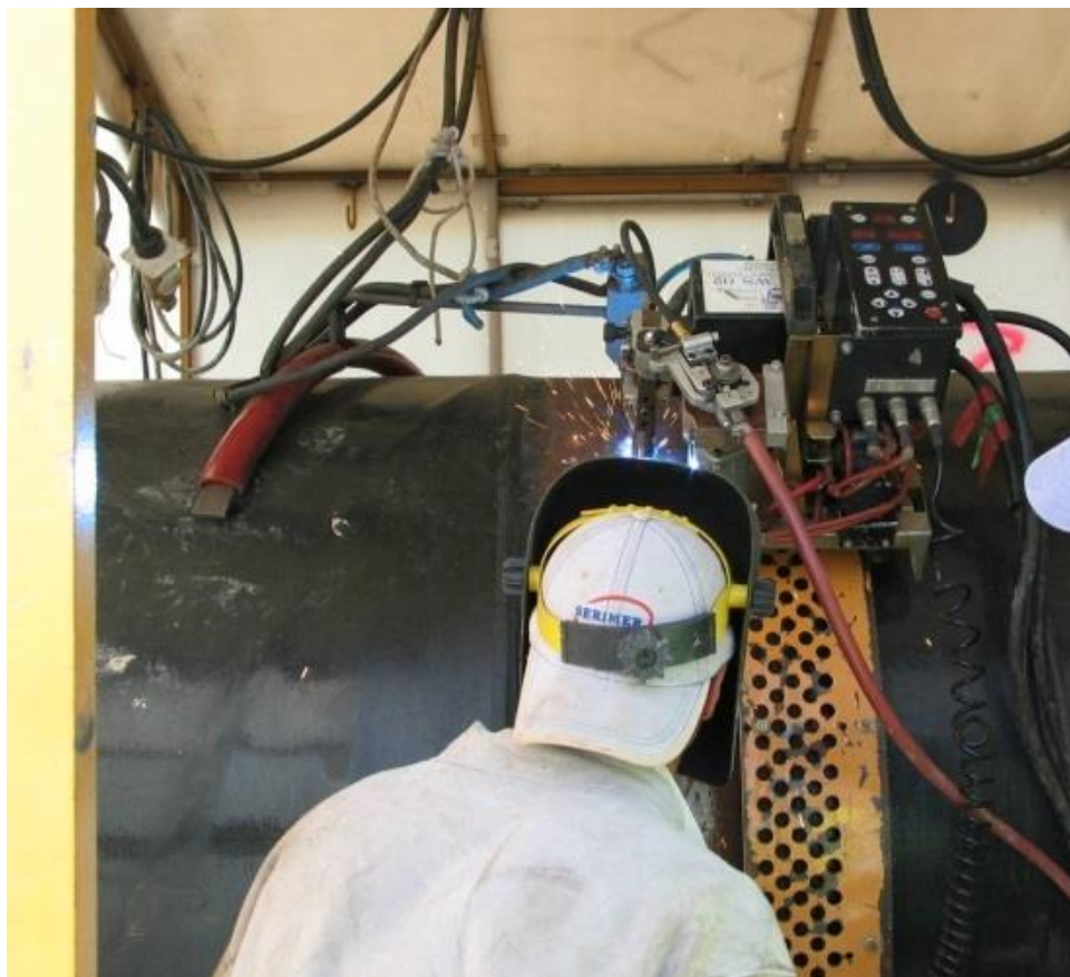
Foto 3.2/E: Esempio di saldatura di linea
