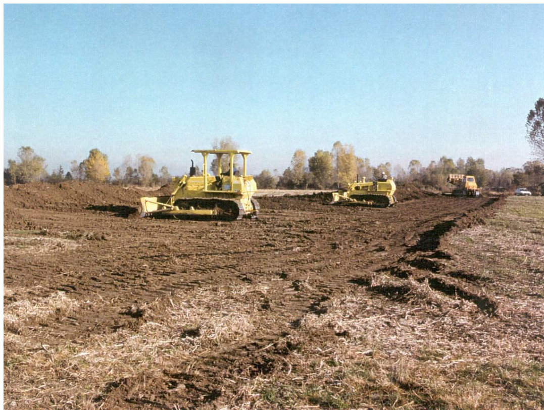
Foto 3.2/C: Esempio di apertura dell'area di passaggio
