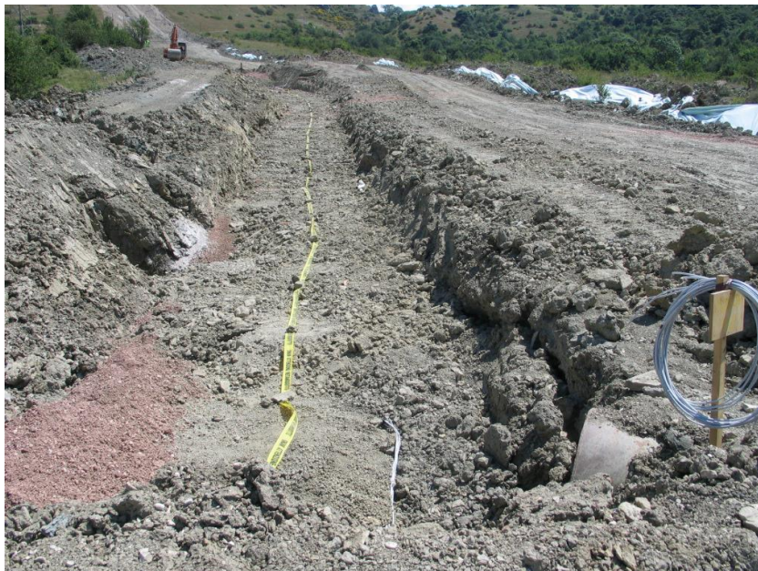
Foto 3.2/H: Esempio di rinterro della condotta.
