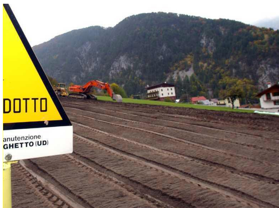
Fig. 3.2/I: Esempio di redistribuzione dello strato superficiale di suolo ( topsoil ).
