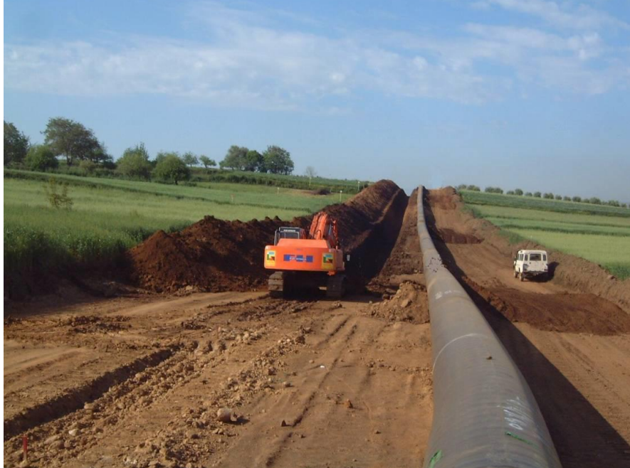
Foto 3.2/F: Esempio di scavo in trincea
