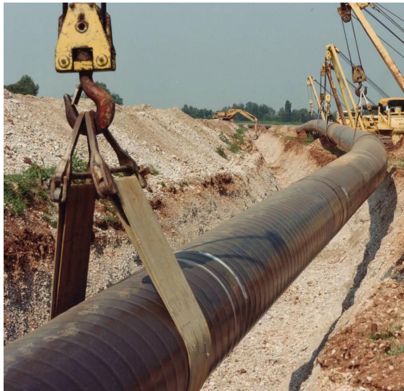
Foto 3.2/G: Esempio di posa della condotta
