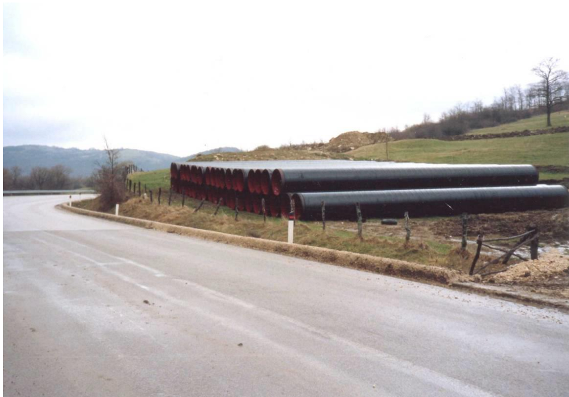
Foto 3.2/B: Esempio di piazzola di accatastamento tubazioni
