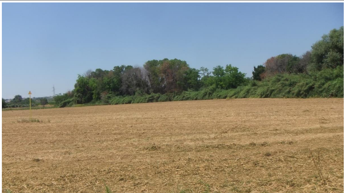
Figura 6.1/B – Panoramica del tracciato in progetto (intorno al km 21) nel comune di Giulianova (UdP - Fondovalle e terrazzi antichi delle alluvioni mesoadriatiche).
