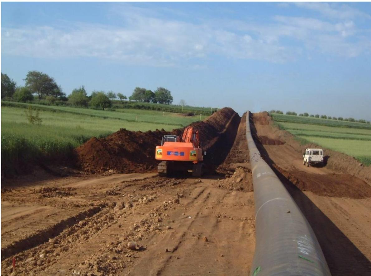
**Foto 2.F:** Esempio di scavo in trincea
