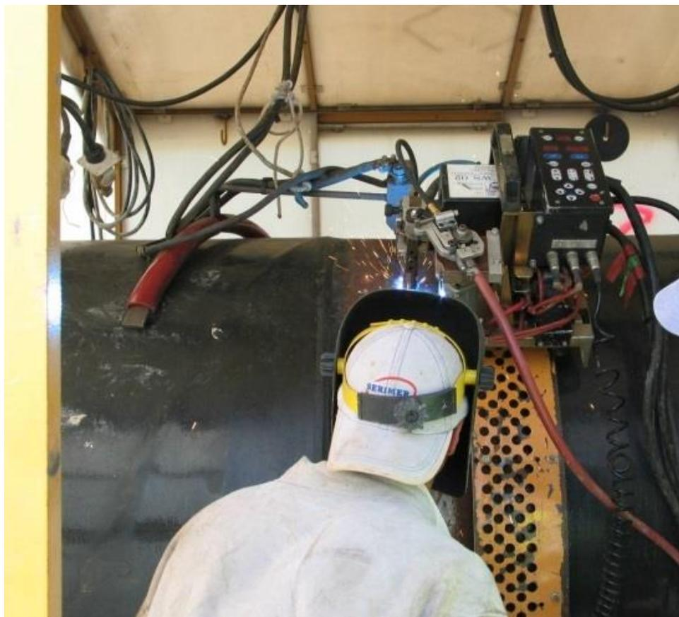
**Foto 2.E:** Esempio di saldatura di linea
