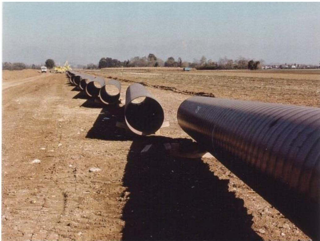
**Foto 2.D:** Esempio di sfilamento tubazioni
