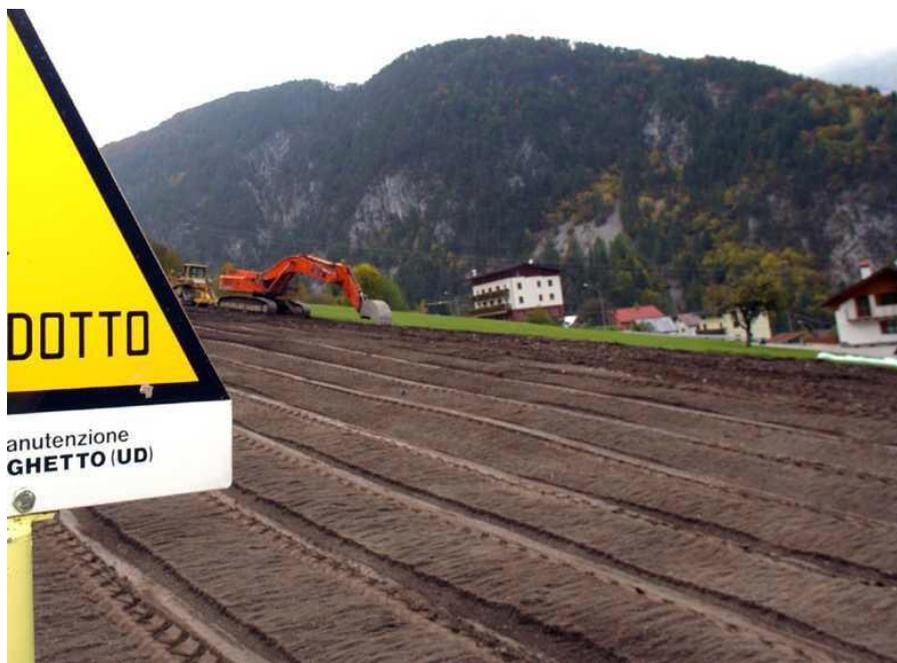
**Foto 2.J:** Esempio di redistribuzione dello strato superficiale di suolo (topsoil).
