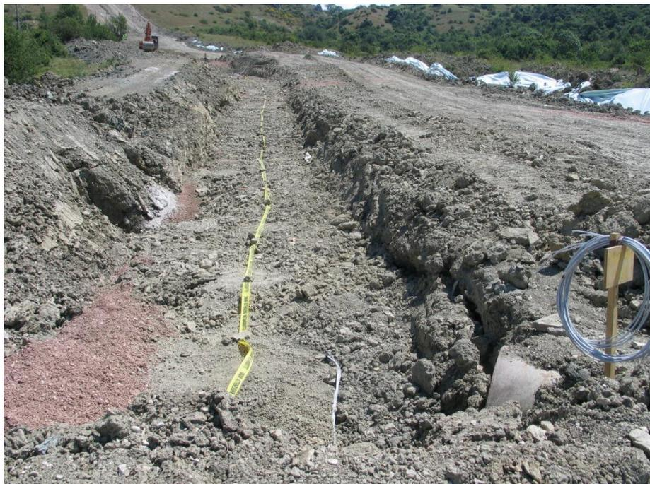
**Foto 2.H:** Esempio di rinterro della condotta.
