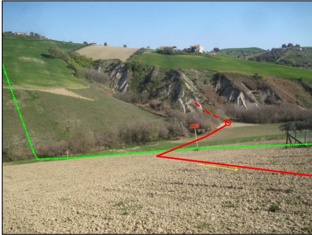
Foto 13: Attraversamento trenchless della dorsale di Mazzarosa-Giammartino
