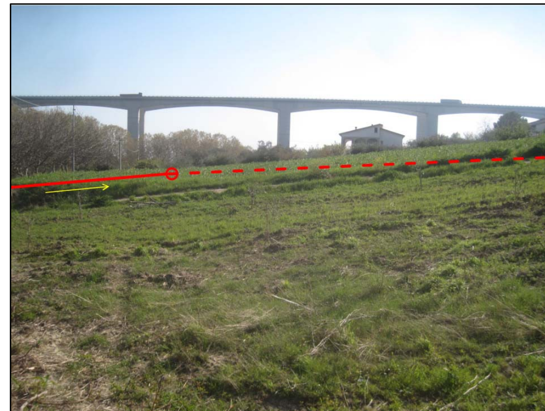
Foto 19: Imbocco settentrionale del microtunnel Colle Cretone 1
