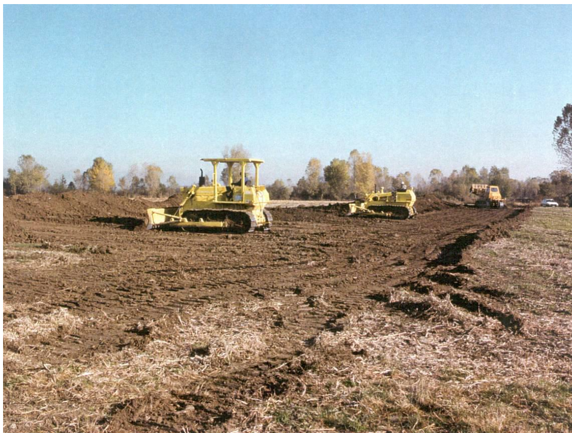
Foto 5.1/C: Esempio di apertura dell'area di passaggio
