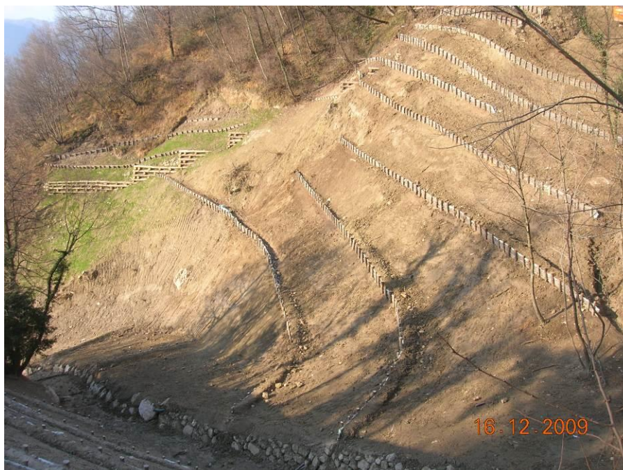
Foto 5.1/K: Esempio di ripristino morfologico e consolidamento di un versante con opere di ingegneria naturalistica (palizzate e palificate)
