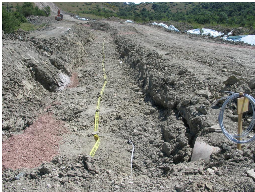
Foto 5.1/H: Esempio di rinterro della condotta.
