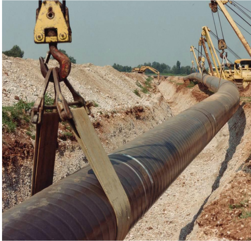
Foto 5.1/G: Esempio di posa della condotta
