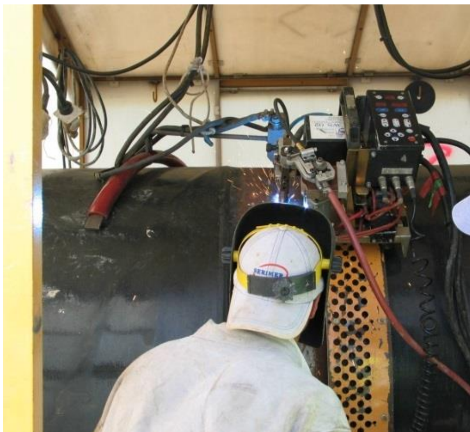
Foto 5.1/E: Esempio di saldatura di linea
