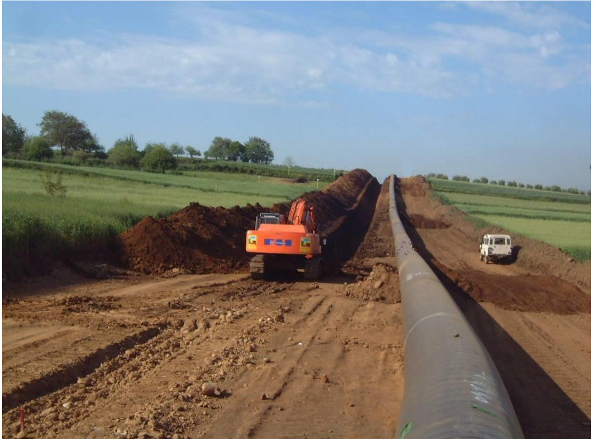
Foto 5.1/F: Esempio di scavo in trincea
