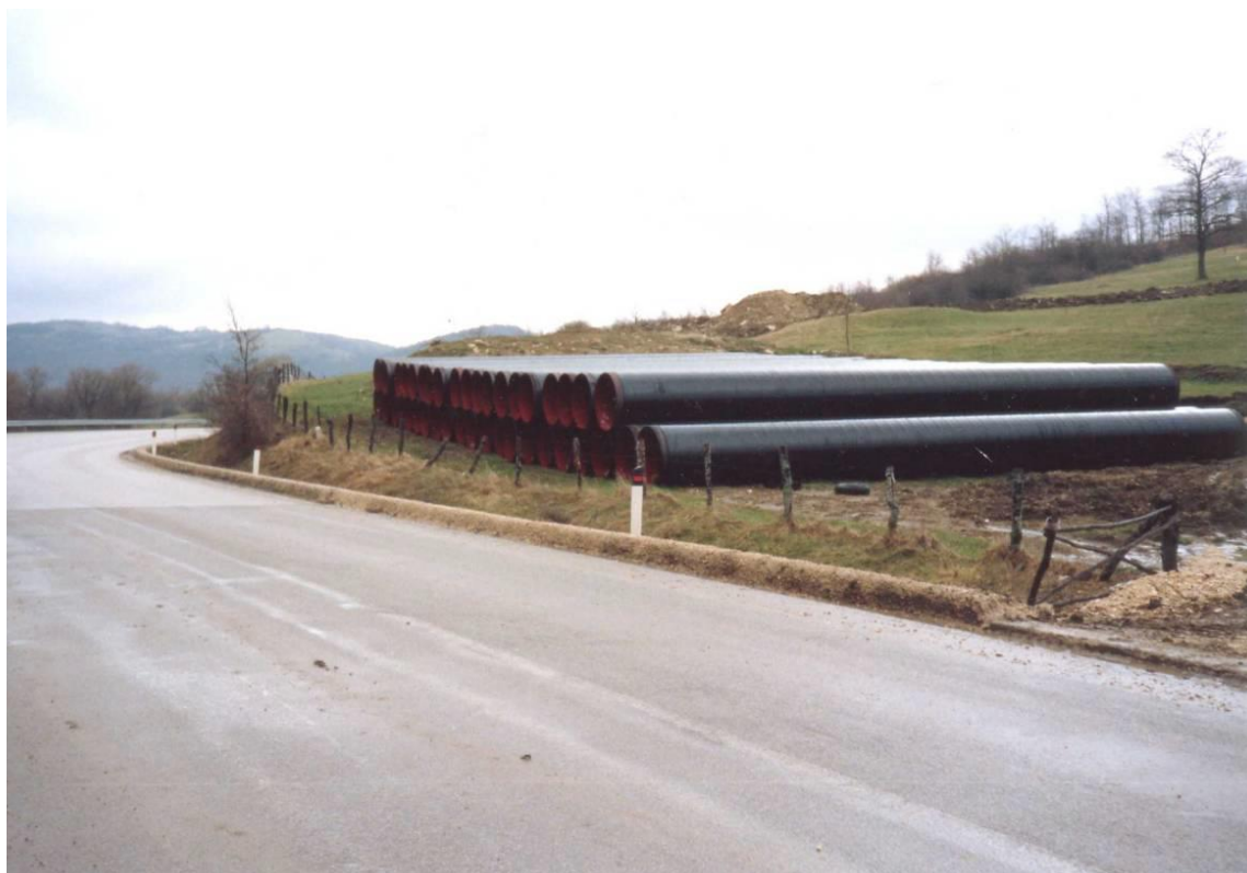
Foto 5.1/B: Esempio di piazzola di accatastamento tubazioni
