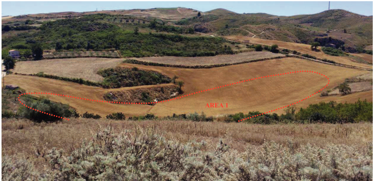
Figura 35 Vista generale dell'Area 1, interessata dagli interventi di miglioramento agraria.
