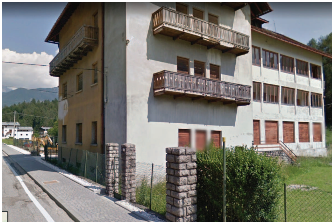
Fronte della ex Colonia del comune di Montagnana in ingresso all'abitato di Tai di Cadore
