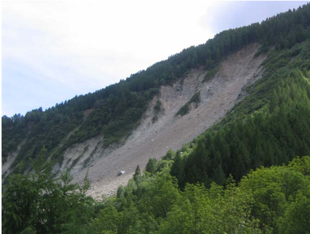
Figura 3-1 - Panoramica Frana “A”.
