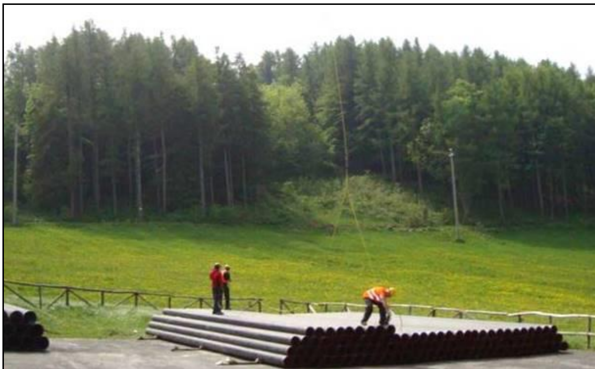
Fig. 5.1/A: Piazzola di accatastamento tubazioni
