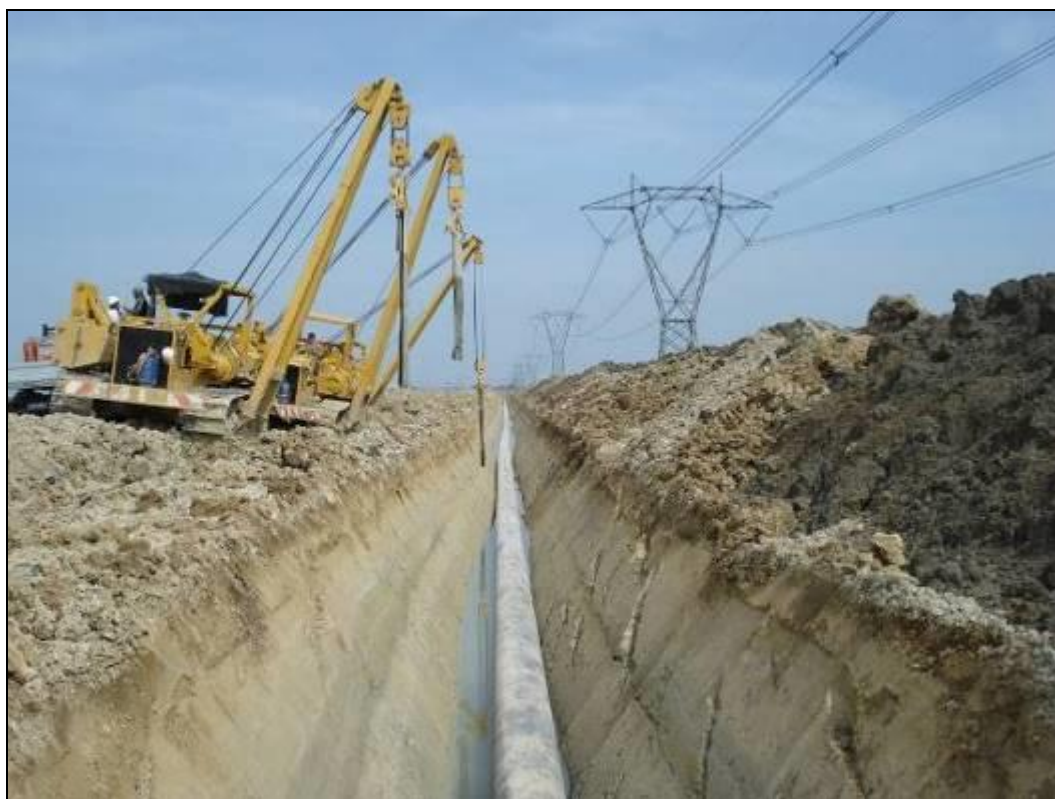
Fig. 5.1/G: Posa della condotta
