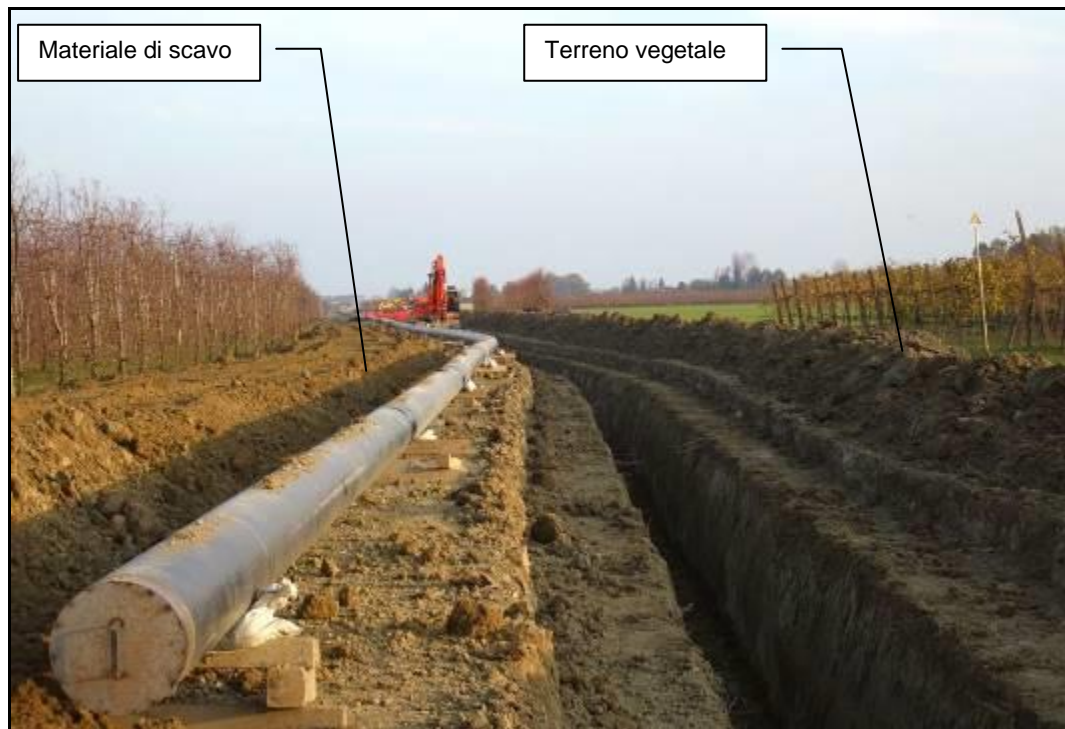
Fig. 5.1/F: Scavo della trincea
