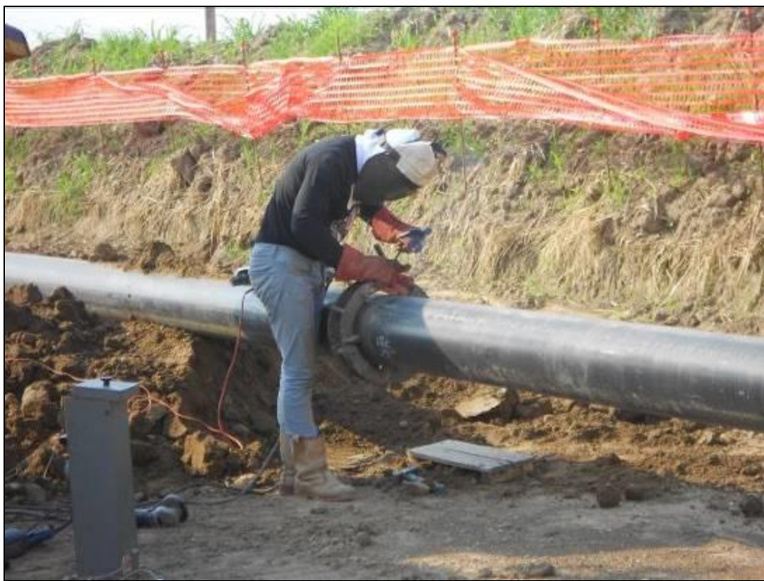
Fig. 5.1/D: Saldatura della tubazione
