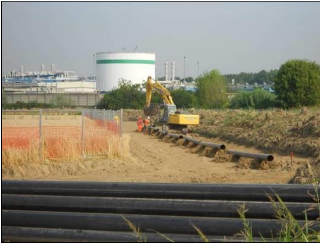
Fig. 5.1/C: Sfilamento tubi
