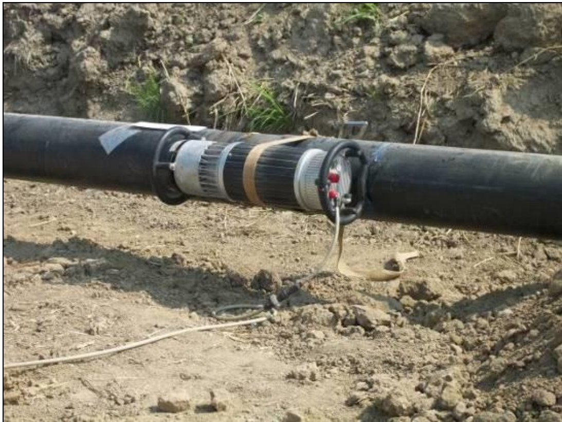
Fig. 5.1/E: Controlli non distruttivi delle saldature
