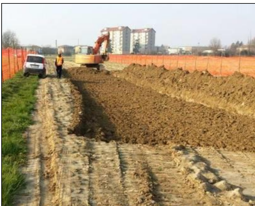
Fig. 5.1/B: Apertura della pista di lavoro
