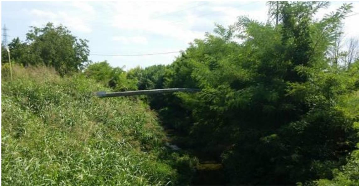
**Figura 2.4/E – Attraversamento aereo da dismettere**
