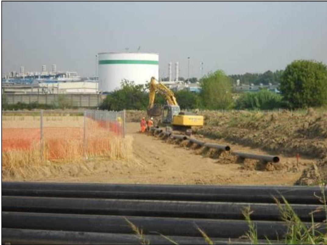
**Fig. 9.1/C: Sfilamento tubi**
