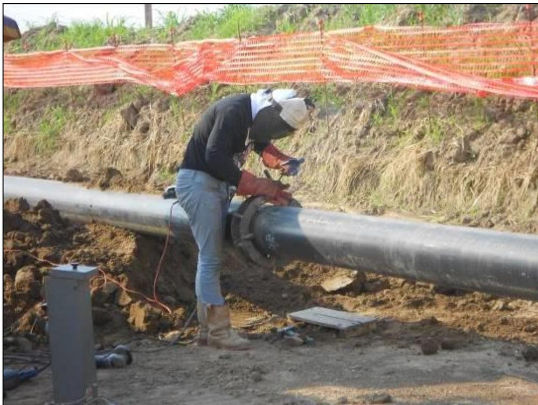
**Fig. 5.1/D: Saldatura della tubazione**
