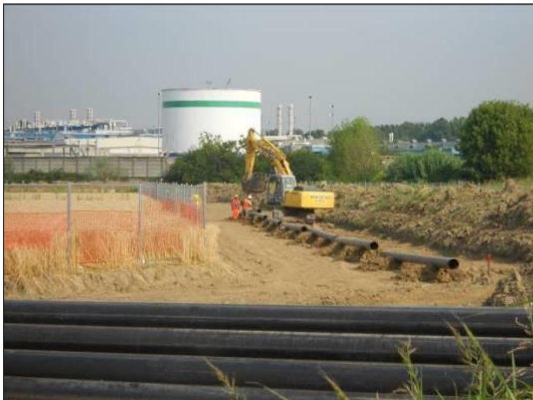
**Fig. 5.1/C: Sfilamento tubi**
