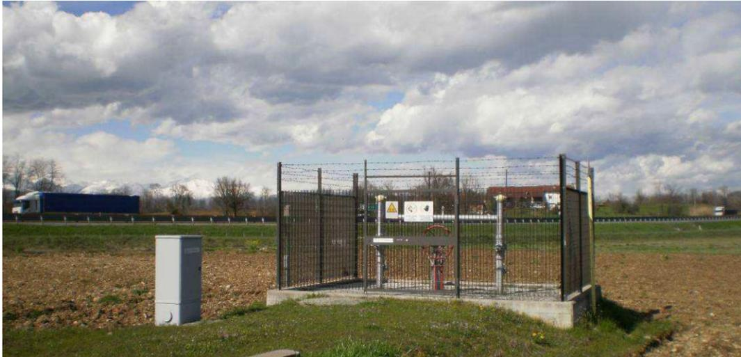
**Fig. 2.3/H – Punto di Intercettazione di Linea (PIL)**
