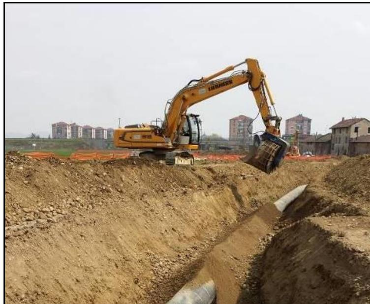
**Fig. 2.3/D: Rinterro della condotta**
