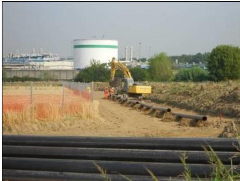
**Fig. 2.2.5/C: Sfilamento tubi**
