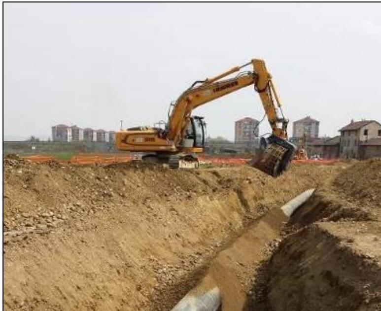
**Fig. 2.2.5/E: Rinterro della condotta**
