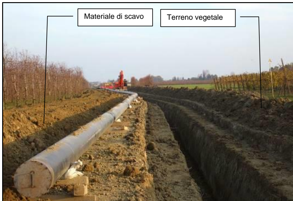
Fig. 5/D: Scavo della trincea
