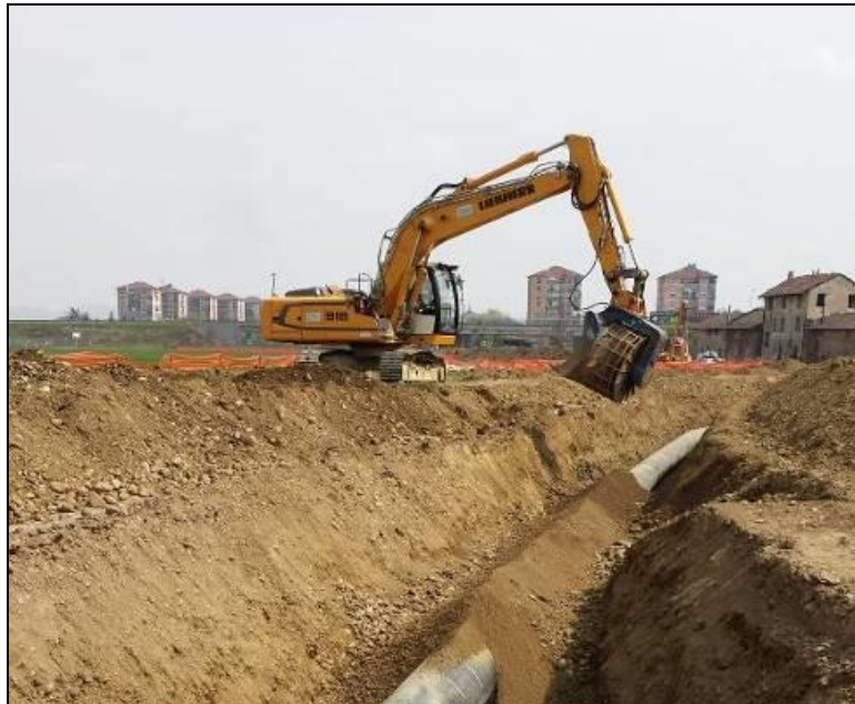
Fig. 5/E: Rinterro della condotta
