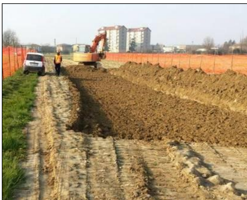
Fig. 5/B: Apertura della pista di lavoro
