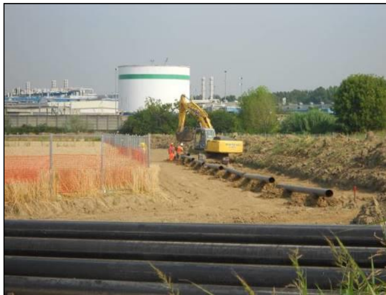
Fig. 5/C: Sfilamento tubi
