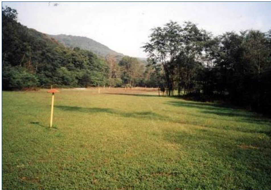
Fig. 5.1 – Fascia di lavoro ad opera ultimata su un gasdotto in esercizio
