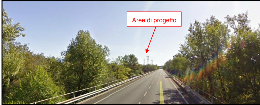
Figura 4.9.2.2b Vista dalla S.R. n.117 nel tratto in attraversamento sul Fiume Isonzo
