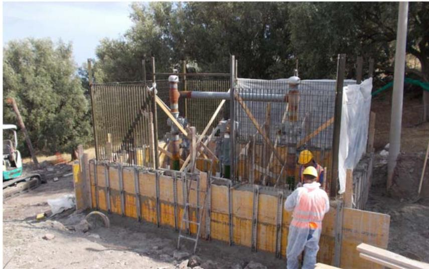
**Foto 4.1/L: Costruzione di un punto di intercettazione di linea (P.I.L.)**
