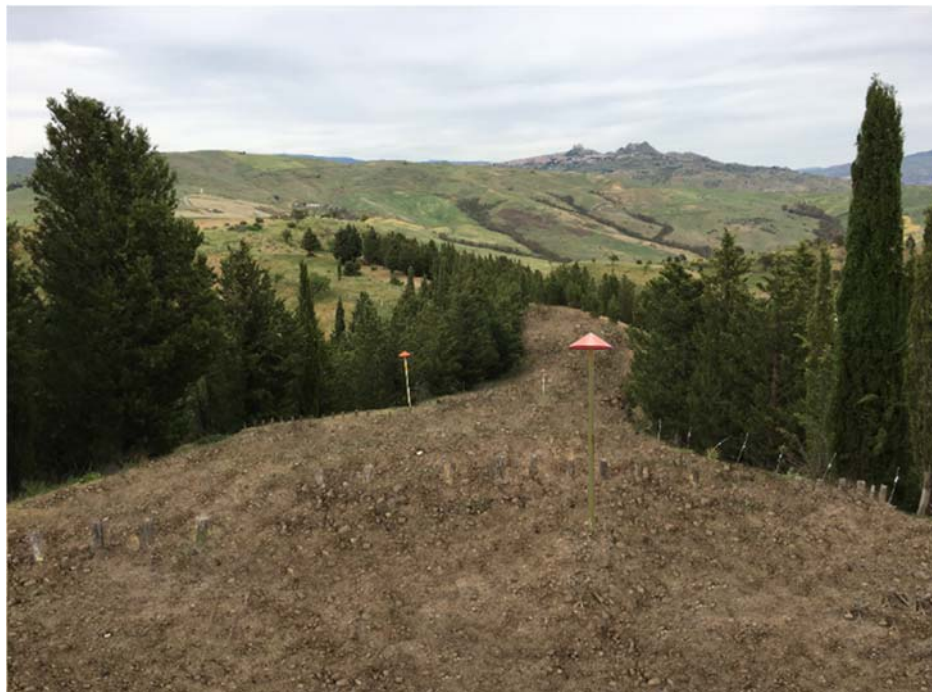
Figura 3/T: Rinterro della condotta
