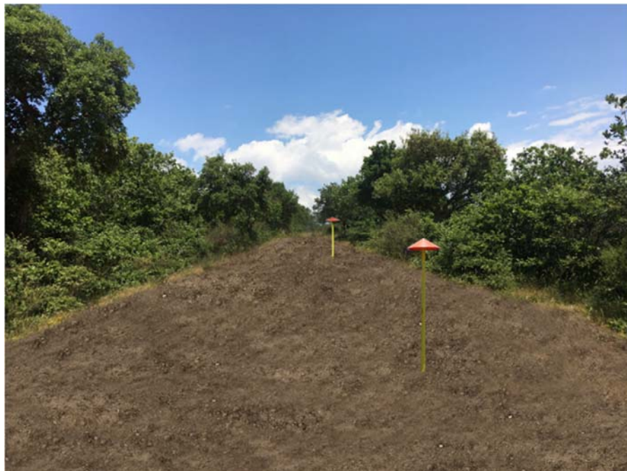
Figura 3/AA: Rinterro della condotta
