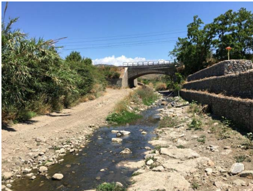
Foto 3/M: Met. Gagliano-Termini I. DN 300 in progetto: Attraversamento del Vallone Ecce nel Comune di Sciara
