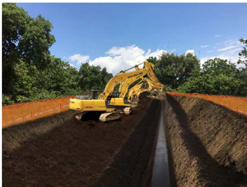
Figura 3/Z: Posa della condotta nella trincea di alloggiamento della condotta
