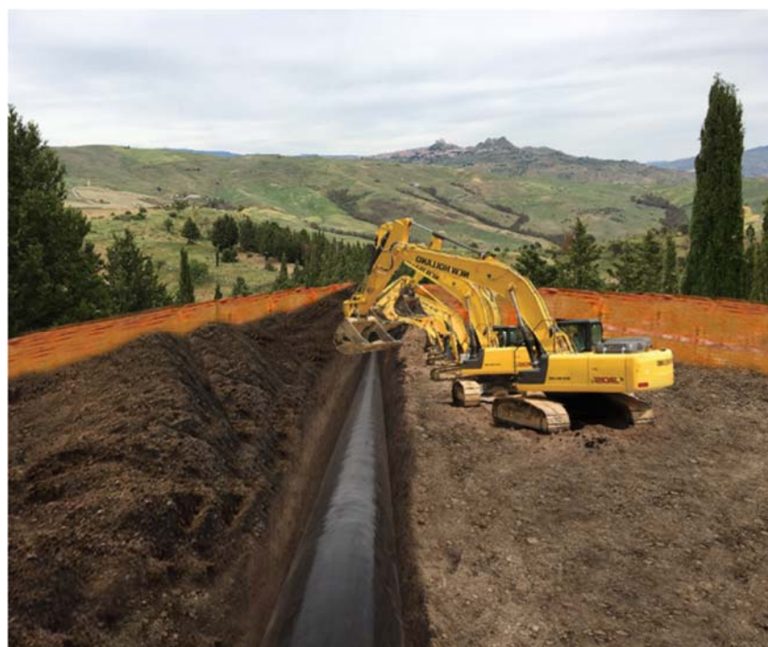
Figura 3/S: Posa della condotta nella trincea di alloggiamento della condotta
