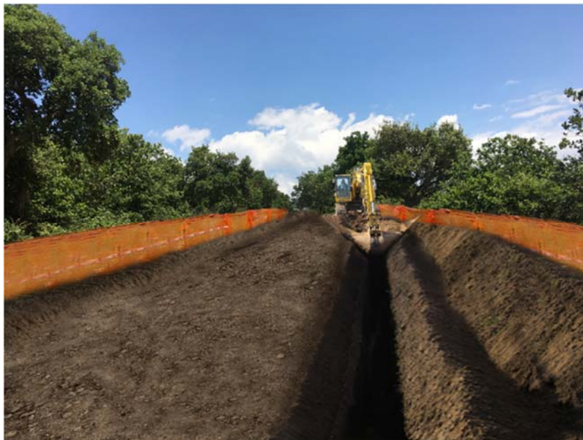
Figura 3/Y: Realizzazione della trincea di alloggiamento della condotta
