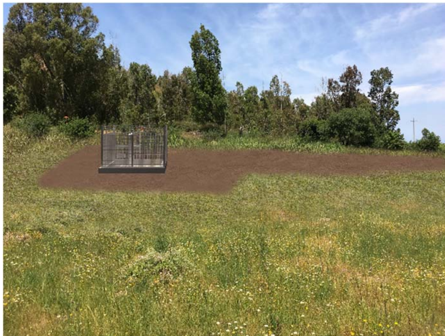
Figura 3/AE: Realizzazione del nuovo impianto P.I.L. n.1 – Rifacimento Allacciamento al Comune di Collesano DN 150 (6'') DP 75 bar MOP 24 bar
