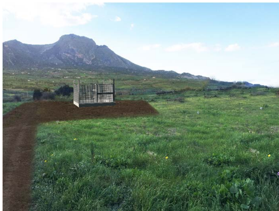
Figura 3/AJ: Realizzazione del nuovo impianto P.I.L. n.2 – Rifacimento Allacciamento al Comune di Cerda DN 100 (4'') DP 75 bar MOP 24 bar
