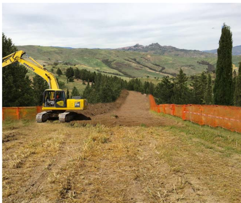
Figura 3/Q: Apertura dell'area di passaggio
