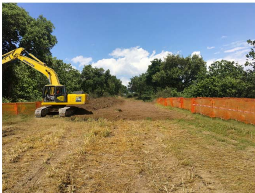
Figura 3/X: Apertura dell'area di passaggio
