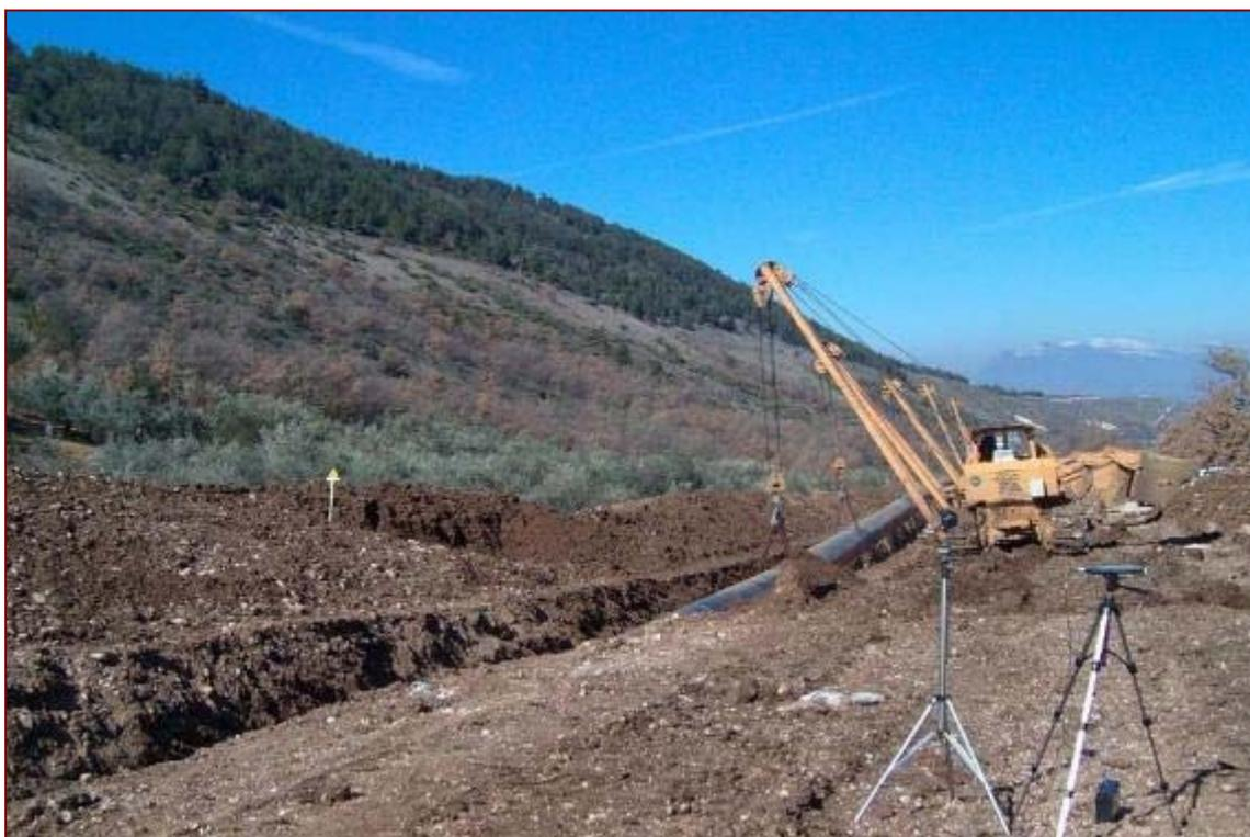
La strumentazione di misura utilizzata è costituita da: fonometro, cavo, preamplificatore e microfono.
