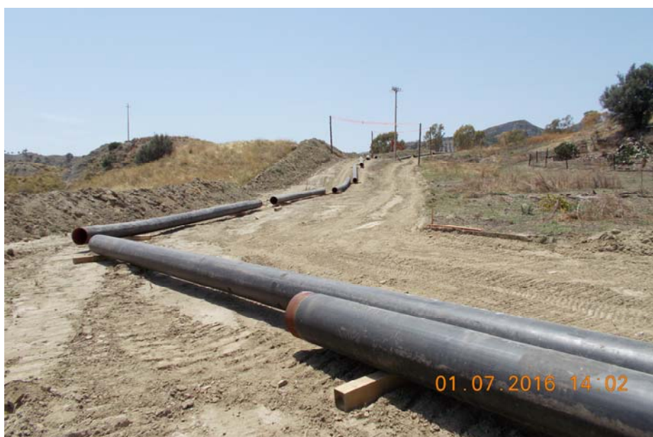
Foto 5.1/C: Sfilamento tubazioni
