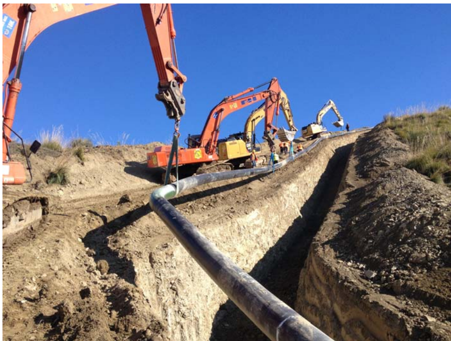
Foto 5.1/F: Posa della condotta
