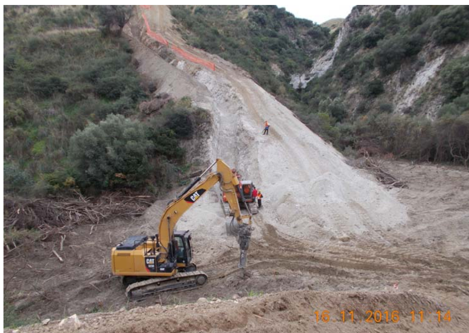
Foto 5.1/E: Scavo della trincea
