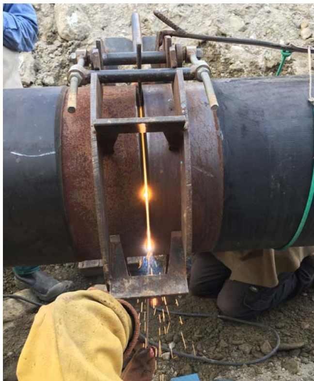
Foto 5.1/D: Saldatura tubazioni
