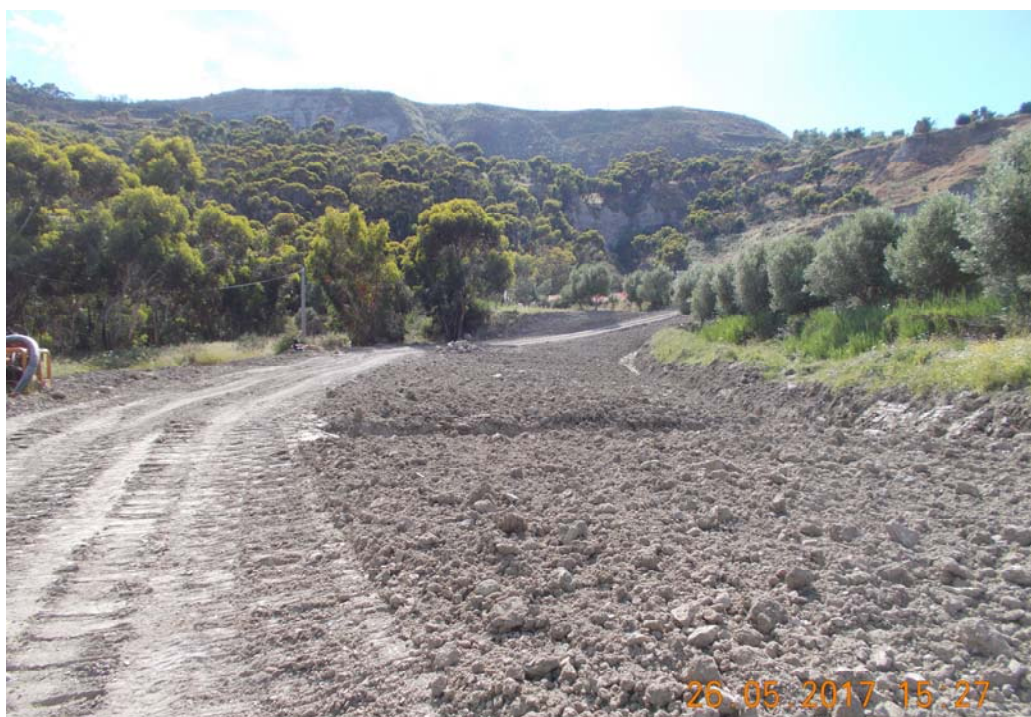
Foto 5.1/G: Rinterro della condotta
