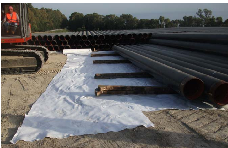
Foto 5.1/A: Piazzola di accatastamento tubazioni
