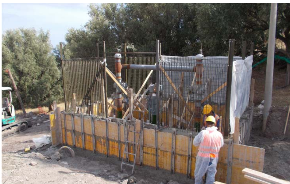
Foto 5.1/I: Costruzione di un punto di intercettazione
