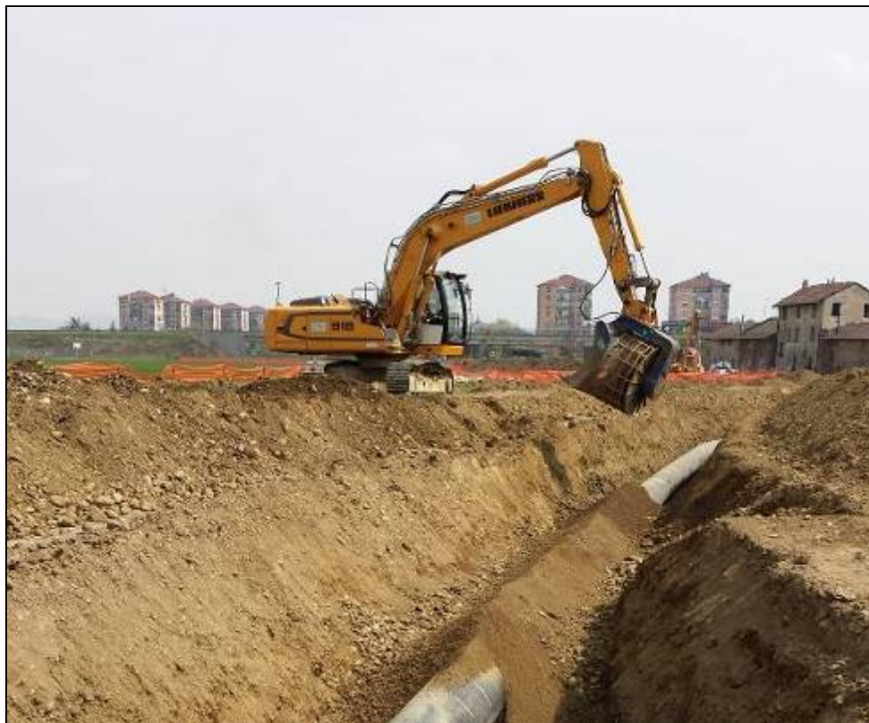
Fig. 5.1/H: Rinterro della condotta
