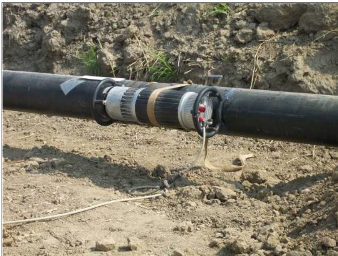
Fig. 5.1/E: Controlli non distruttivi delle saldature
