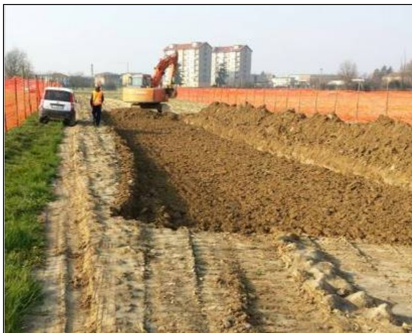
Fig. 5.1/B: Apertura della pista di lavoro
