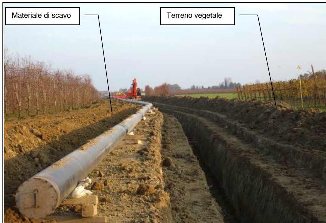
Fig. 5.1/F: Scavo della trincea
