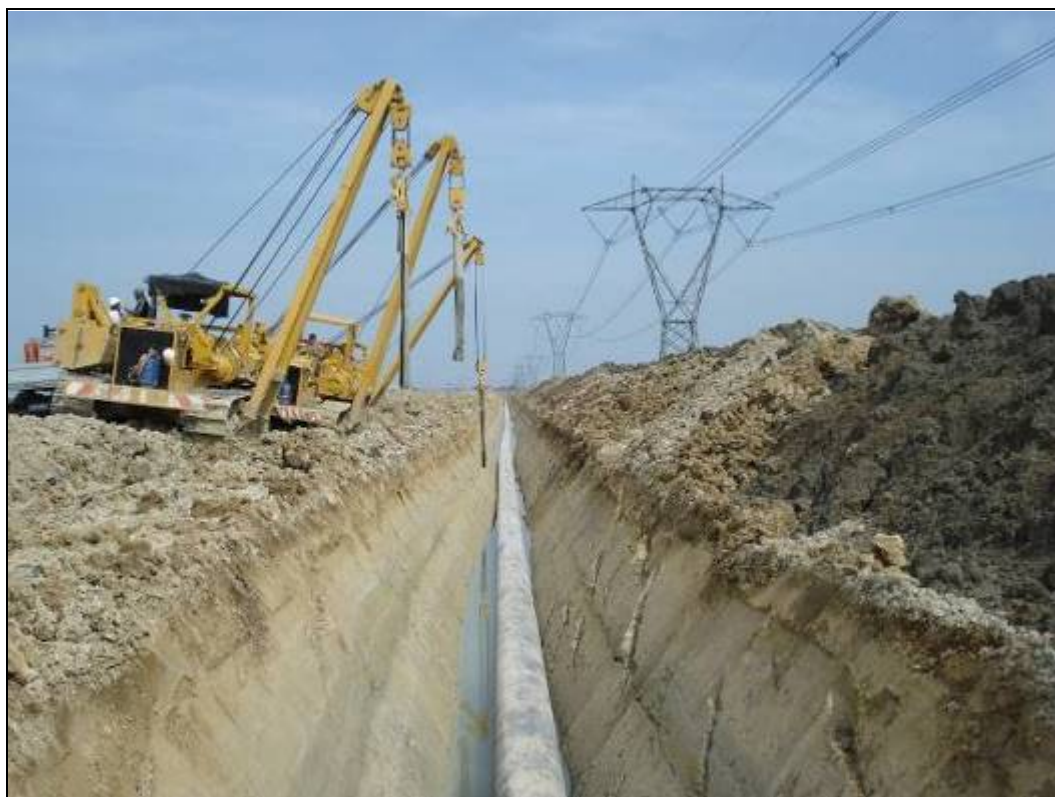
Fig. 5.1/G: Posa della condotta
