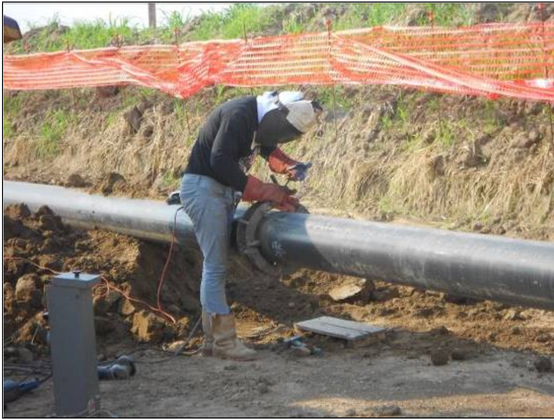
Fig. 5.1/D: Saldatura della tubazione
