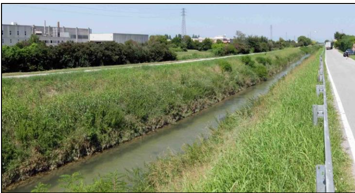
Foto 8 – All. Anselmi: Attraversamento Muson dei Sassi km 1+185 in Spingitubo
