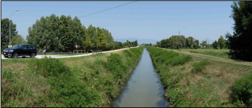
Foto 5 – Attraversamento n. 2 Muson dei Sassi progr. 13+200 in Spingitubo
