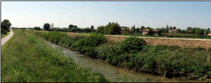
Foto 7 – Attraversamento n. 4 Muson dei Sassi progr. 16+724 in TOC
