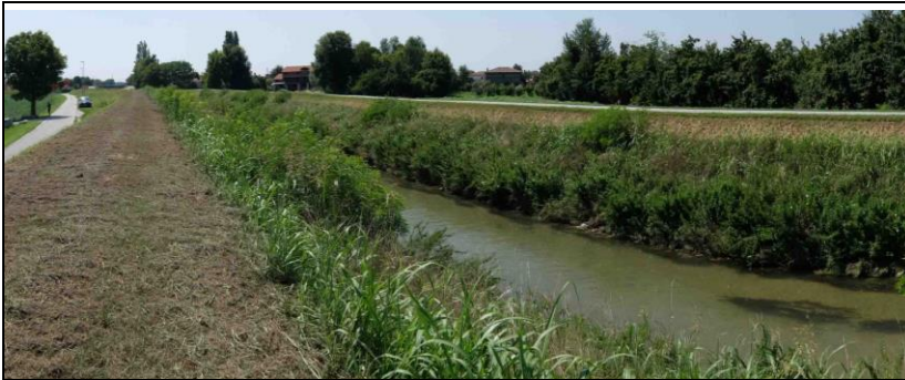
Foto 6 – Attraversamento n. 3 Muson dei Sassi progr. 14+980 in TOC
