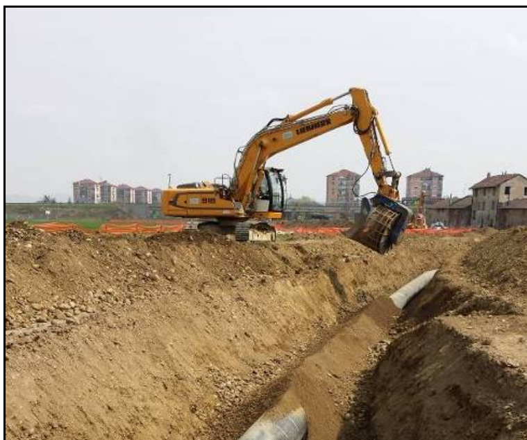
Fig. 9.1/H: Rinterro della condotta
