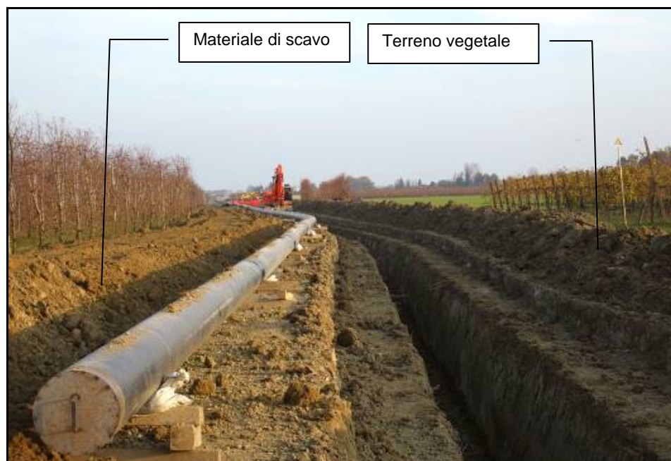
Fig. 9.1/F: Scavo della trincea
