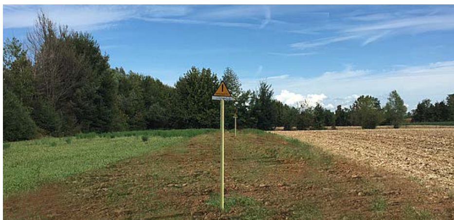
Fig. 4.1/C - Lavori di linea post-operam
