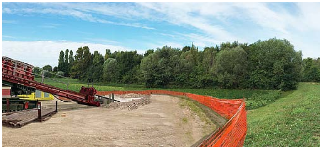
Fig. 4.2/B - TOC fase di cantiere
