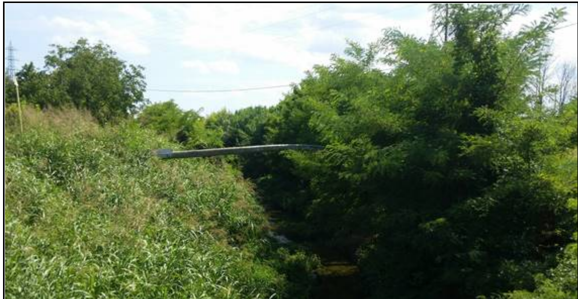
Foto 2.5.2 – Esempio di attraversamento aereo da rimuovere.
