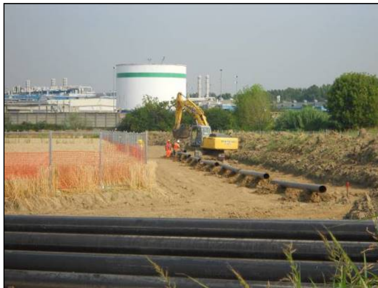
Fig. 9.1/C: Sfilamento tubi
