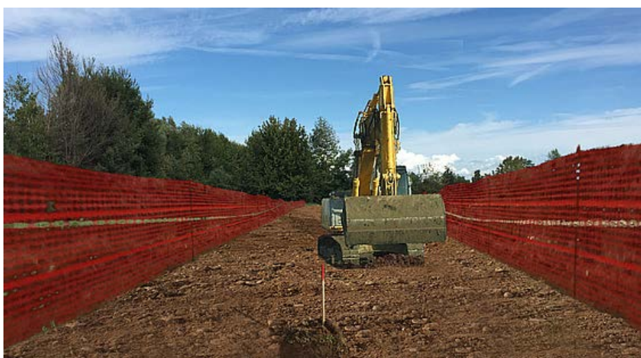
Fig. 4.1/B - Lavori di linea fase di cantiere
