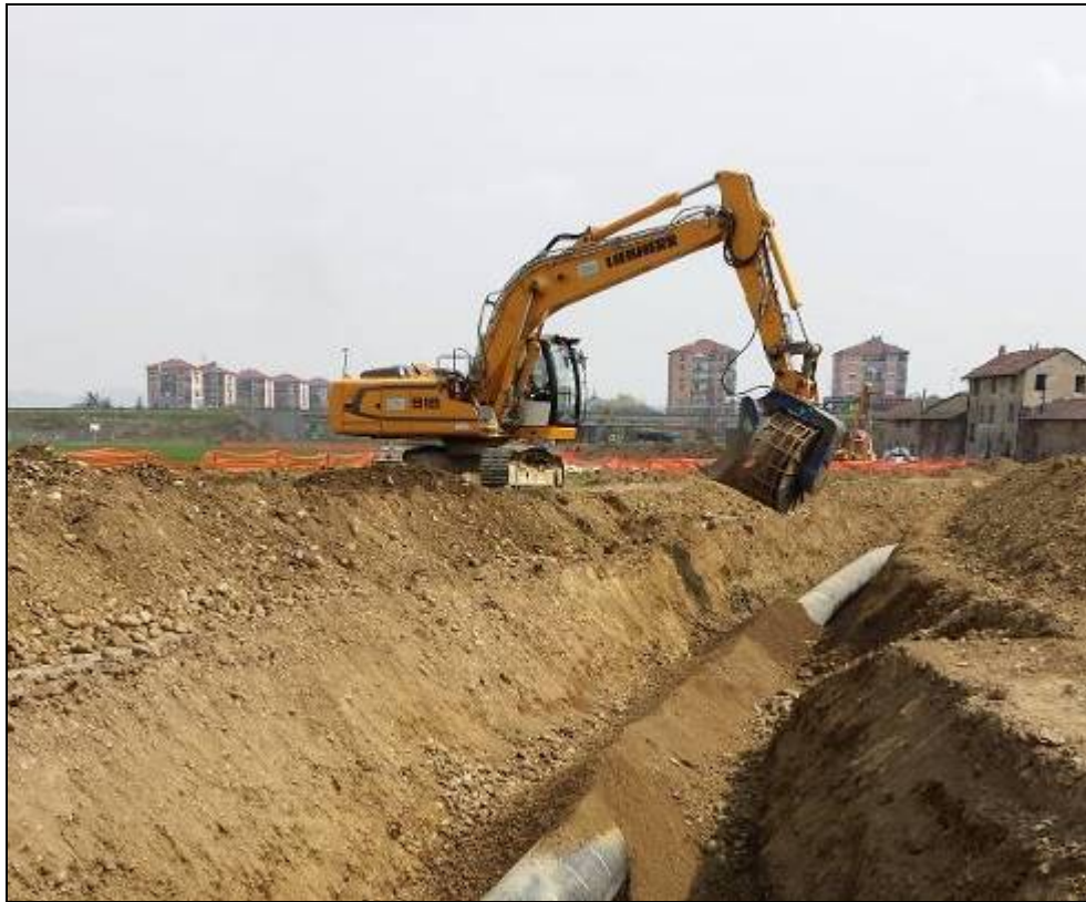
Fig. 5.1/H: Rinterro della condotta
