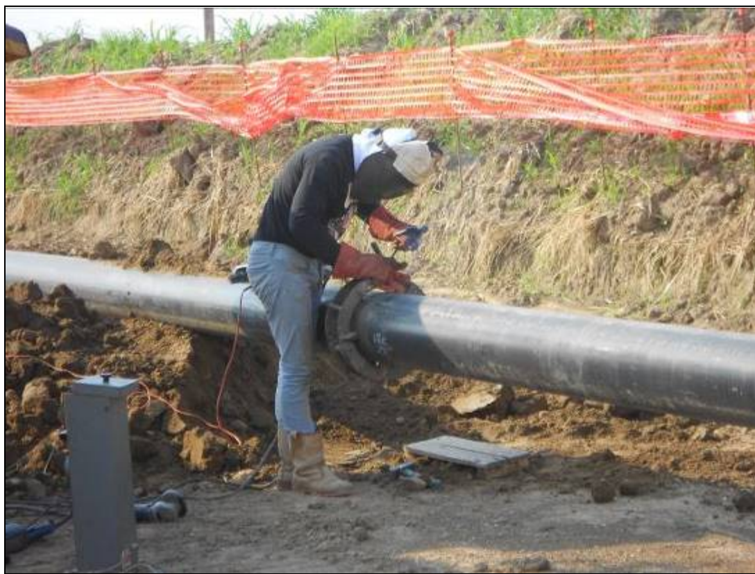
Fig. 5.1/D: Saldatura della tubazione
