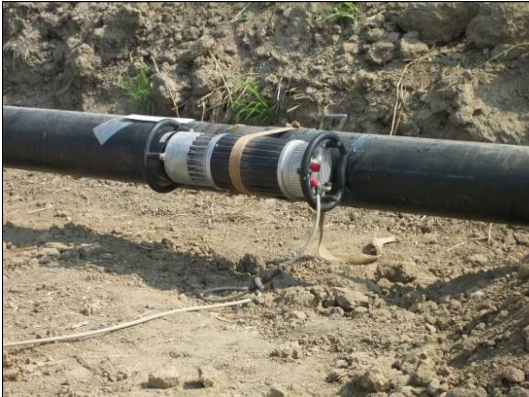
Fig. 5.1/E: Controlli non distruttivi delle saldature
