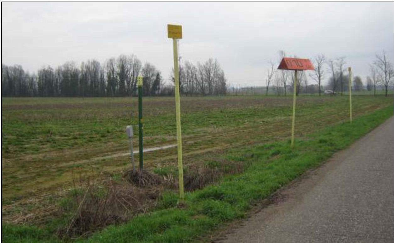
Fig. 9/A: Cartelli segnalatori, cassetta a piantana e tubo di sfiato
