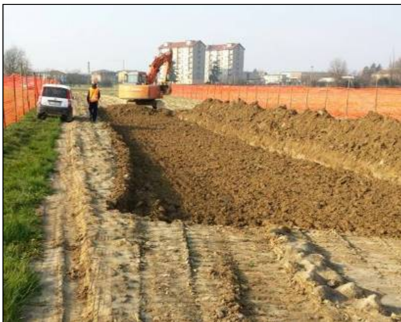
Fig. 5.1/B: Apertura della pista di lavoro
