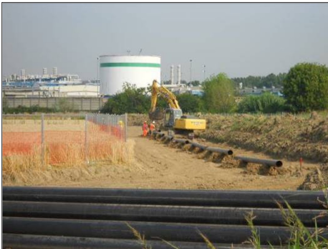
Fig. 5.1/C: Sfilamento tubi
