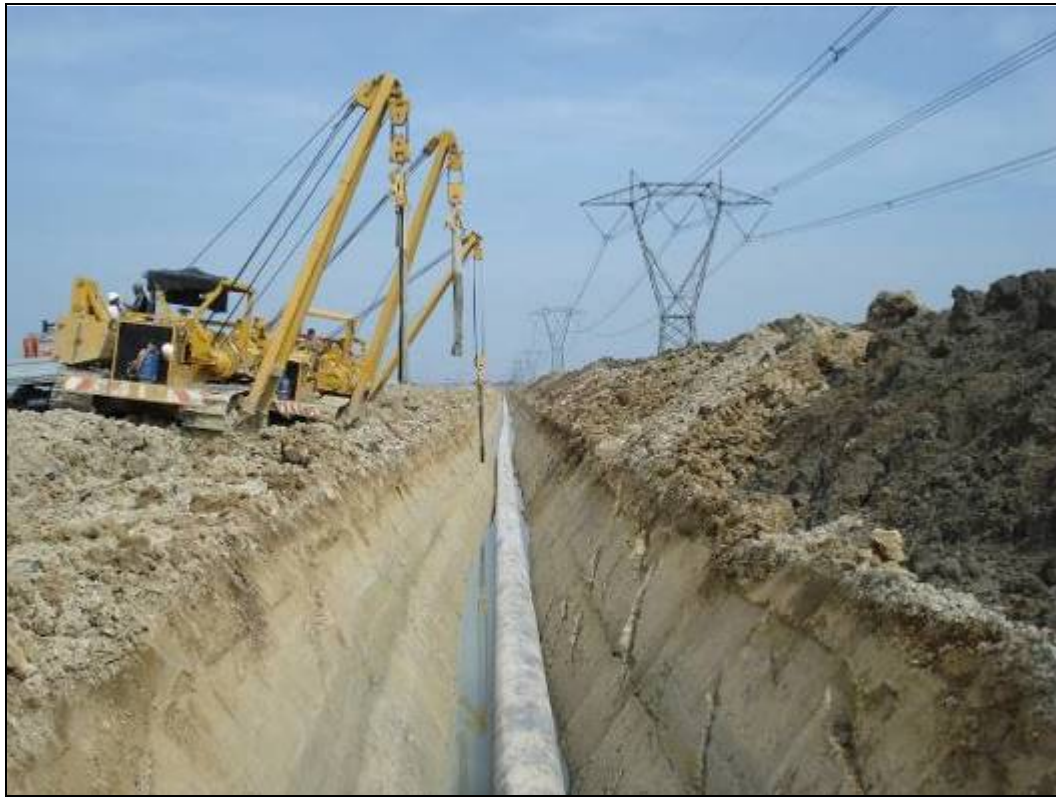
Fig. 5.1/G: Posa della condotta
