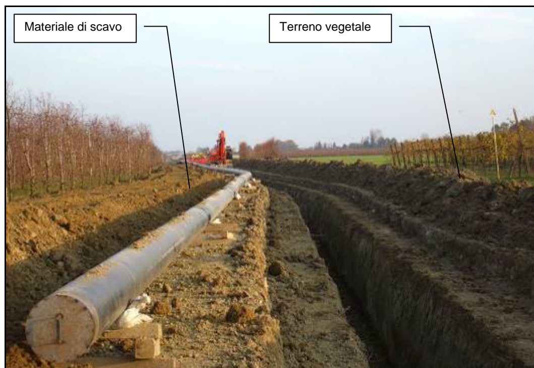
Fig. 5.1/F: Scavo della trincea
