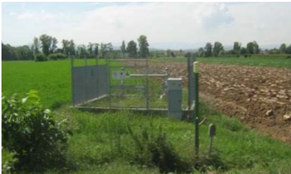
Fig. 9/C: Impianto tipo PIL
