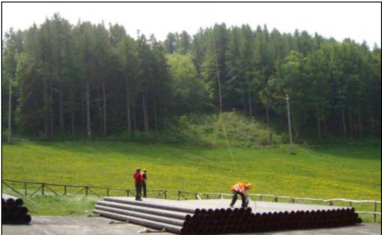
Fig. 5.1/A: Piazzola di accatastamento tubazioni
