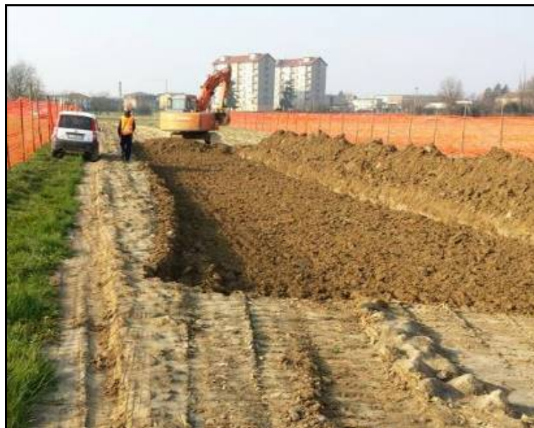
Fig. 2.3/B: Apertura della pista di lavoro
