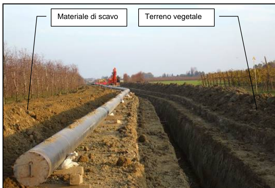
Fig. 2.3/C: Scavo della trincea
