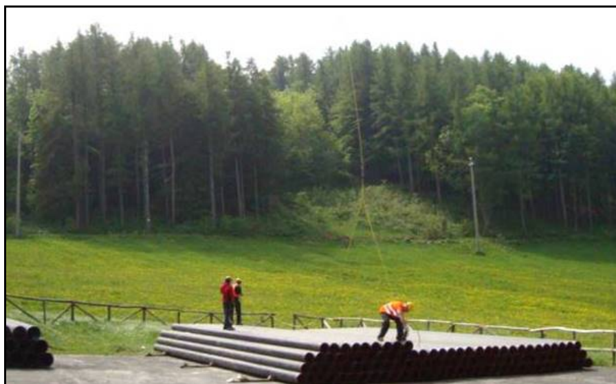
Fig. 2.3/A: Piazzola di accatastamento tubazioni
