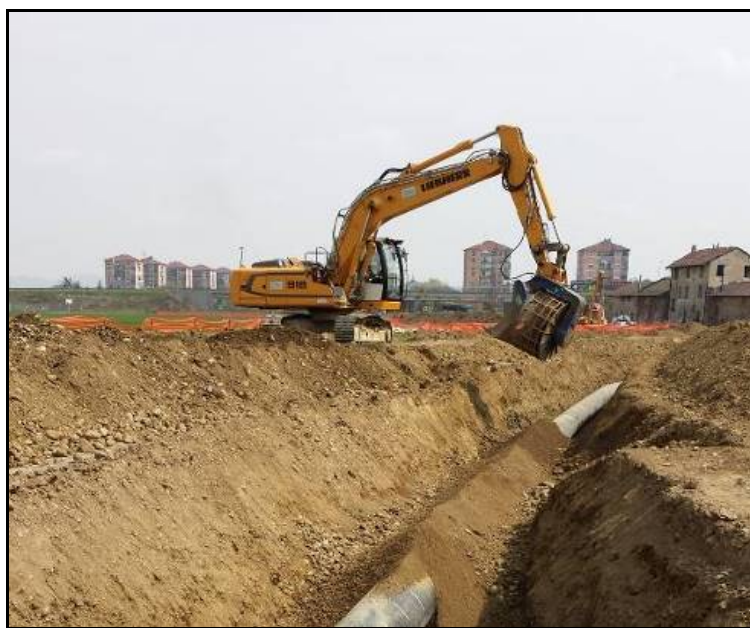
Fig. 2.3/D: Rinterro della condotta
