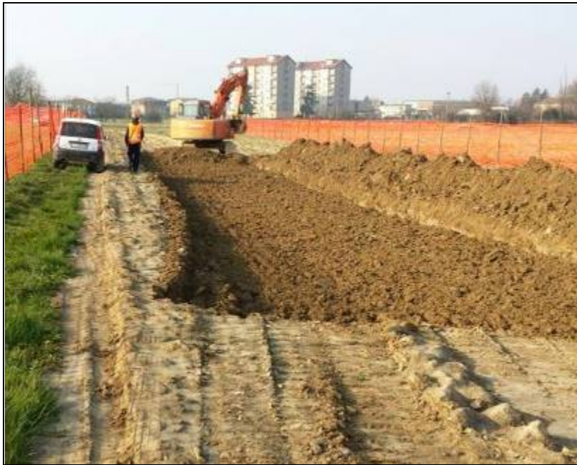
Fig. 2.2.10/B: Apertura della pista di lavoro
