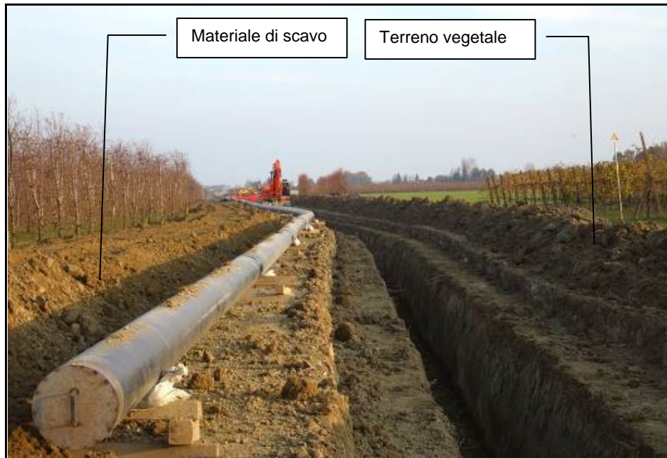
Fig. 2.2.10/D: Scavo della trincea
