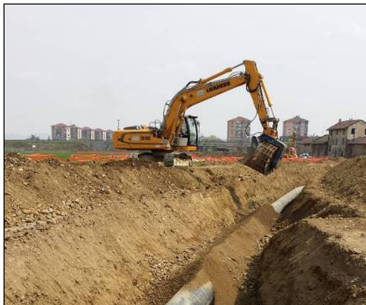
Fig. 2.2.10/E: Rinterro della condotta
