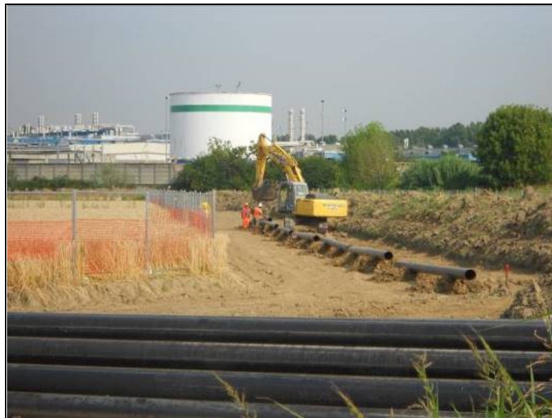
Fig. 2.2.10/C: Sfilamento tubi
