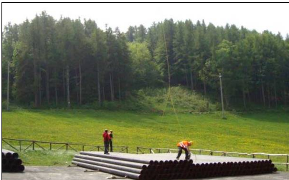
Fig. 2.2.10/A: Piazzola di accatamento tubazioni
