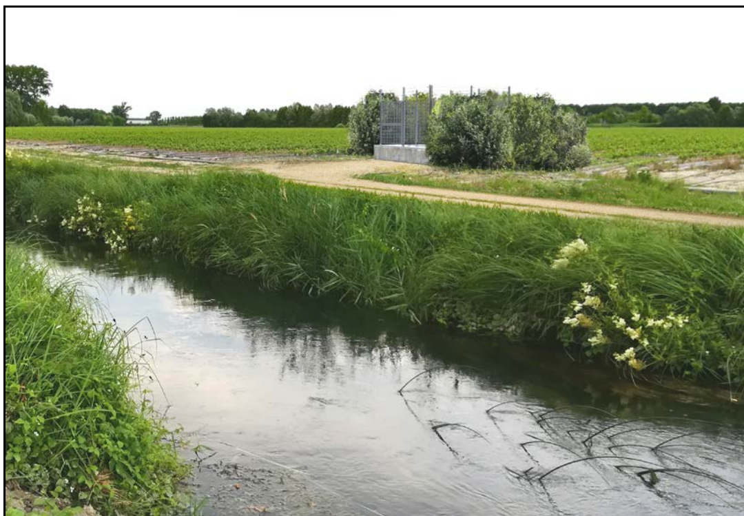
Foto 4.1.A – Esempio di mascheramento di impianto con filare di siepi
