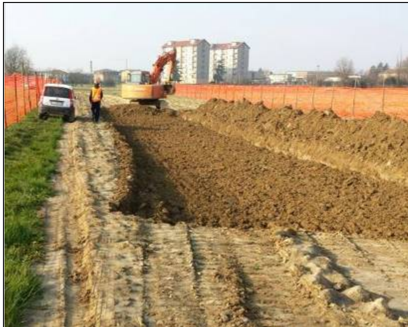
Fig. 5/B: Apertura della pista di lavoro
