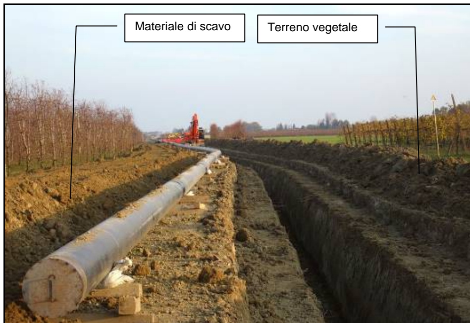
Fig. 5/D: Scavo della trincea
