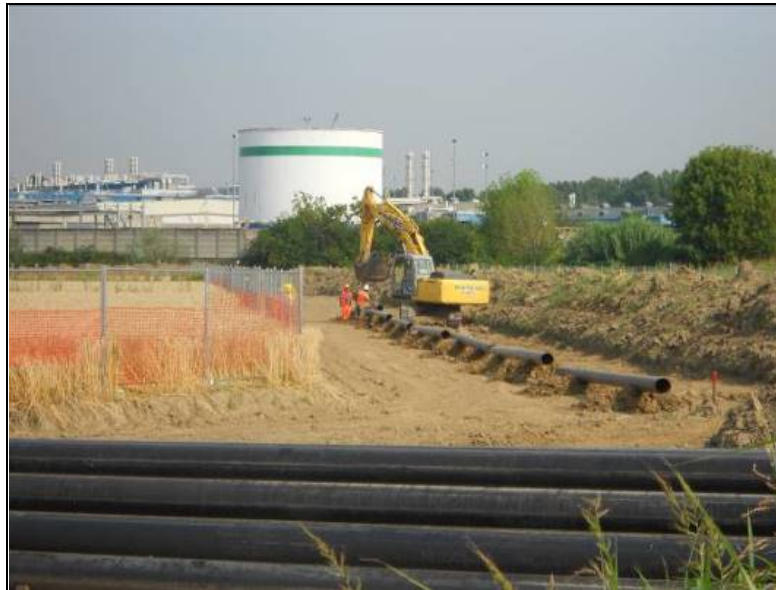
Fig. 5/C: Sfilamento tubi
