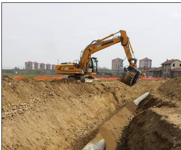
Fig. 5/E: Rinterro della condotta
