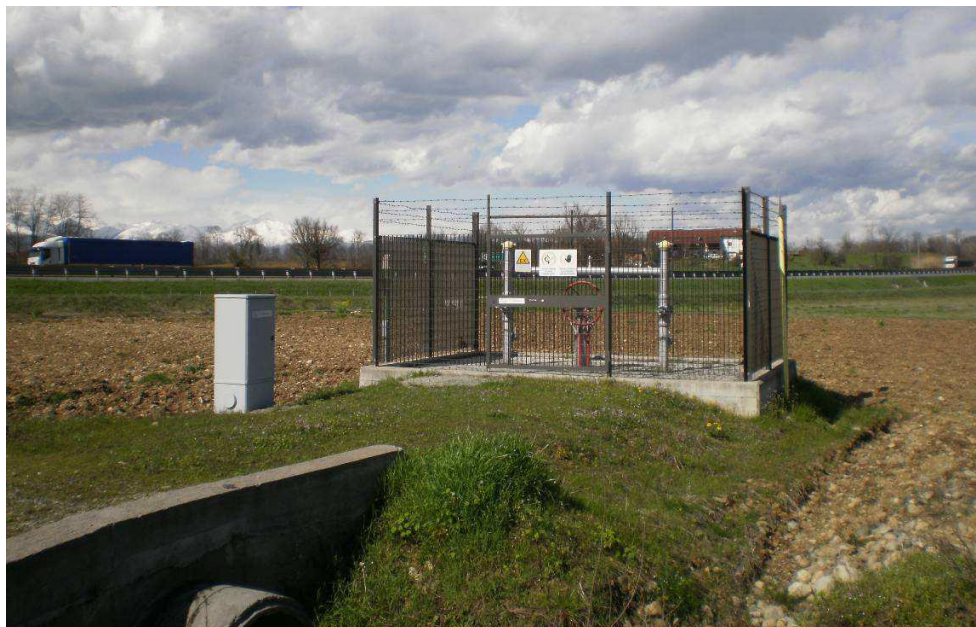
Fig. 3.1.5.10/A – Esempio di Punto di Intercettazione di Linea
