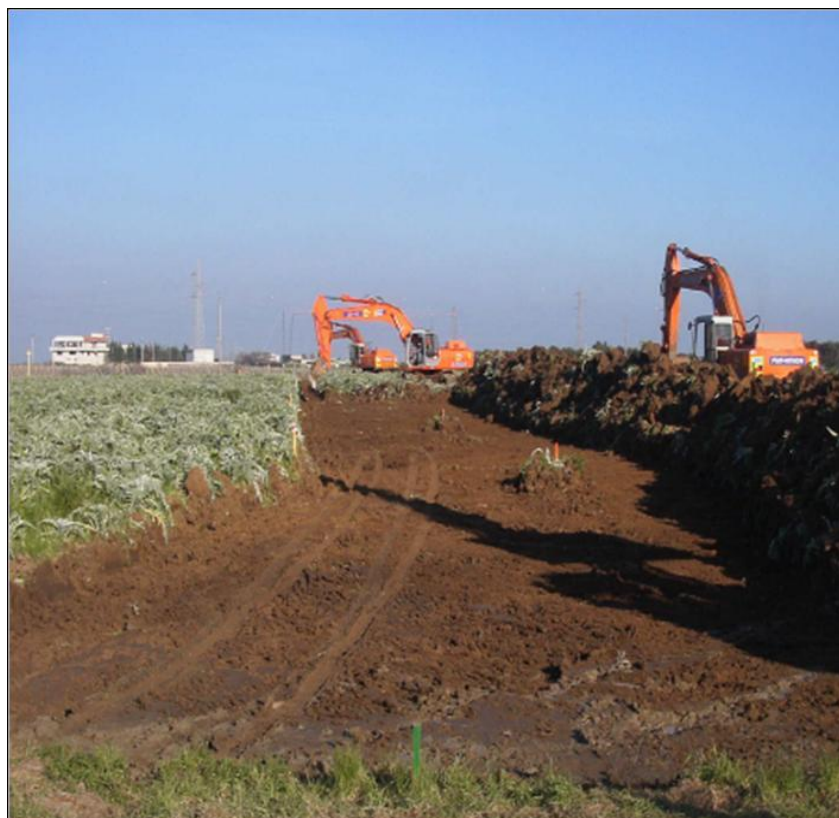
Fig. 3.1.5.2/A – Foto di apertura della pista di lavoro
