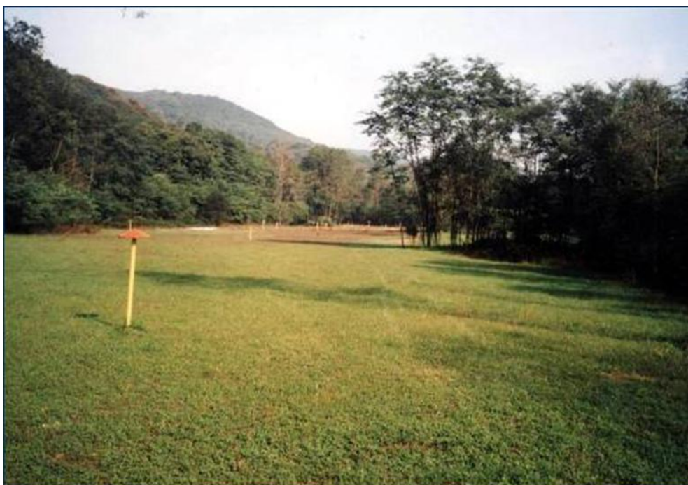
Fig. 3.1.4.11/A – Pista lavori a ripristini ultimati su un gasdotto in esercizio
