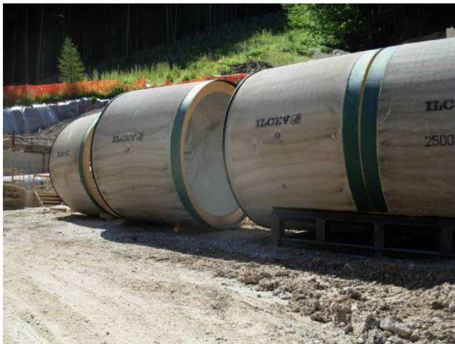
Fig. 3.1.5.9/H – Stoccaggio tubi in c.a.
