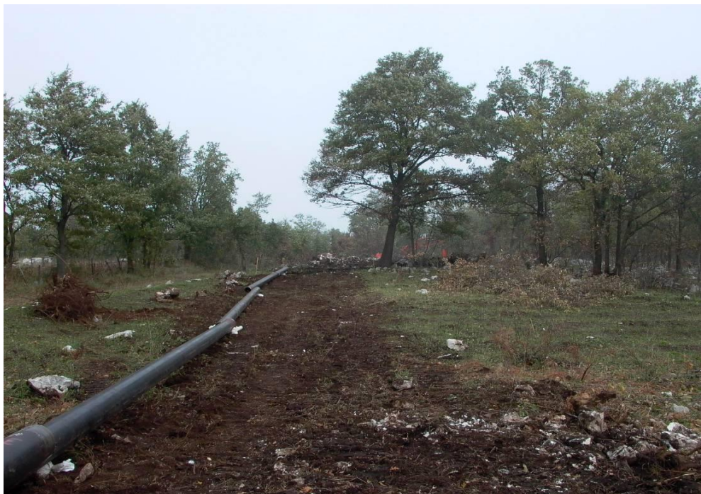
Fig. 3.1.5.4 –Sfilamento tubazioni
