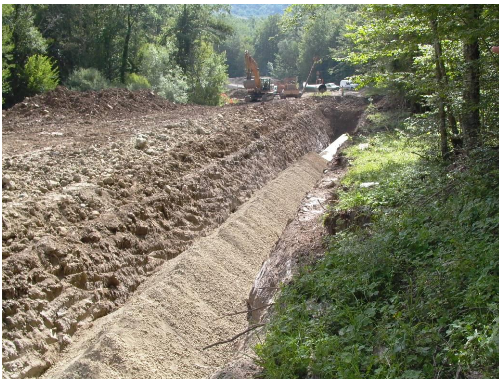
Fig. 3.1.5.8/B – Rinterro della condotta
