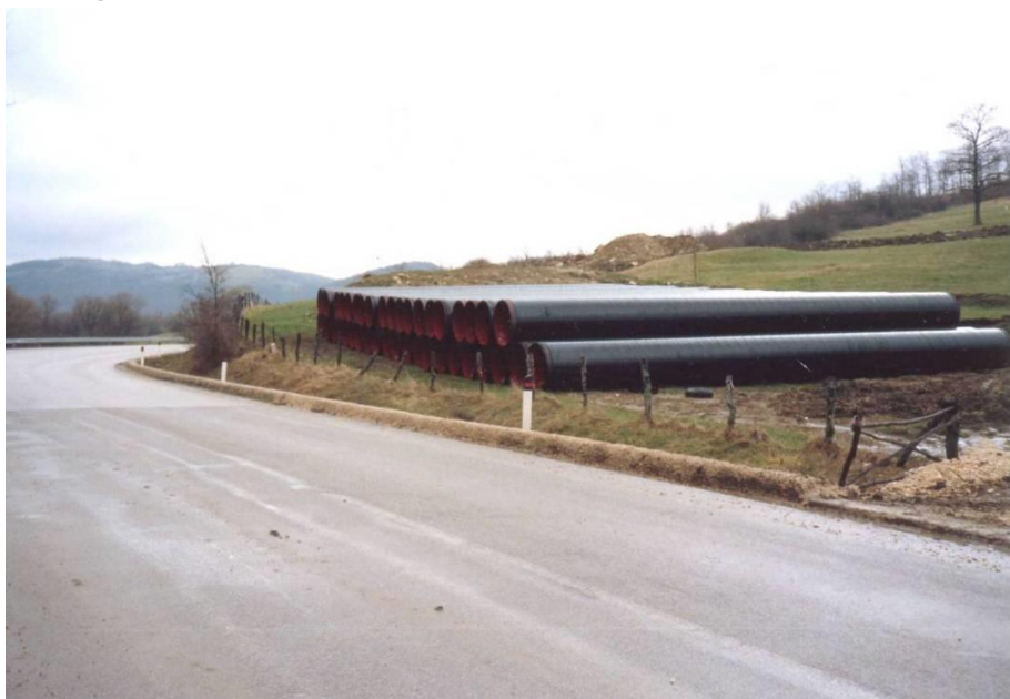
Fig. 3.1.5.1 – Foto tipica di una piazzola per accatastamento tubazioni
