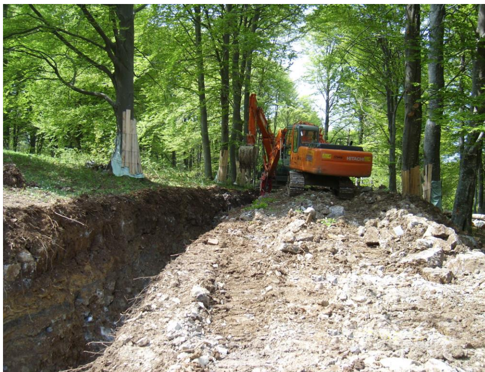
Fig. 3.1.5.6 – Foto tipica di scavo della trincea
