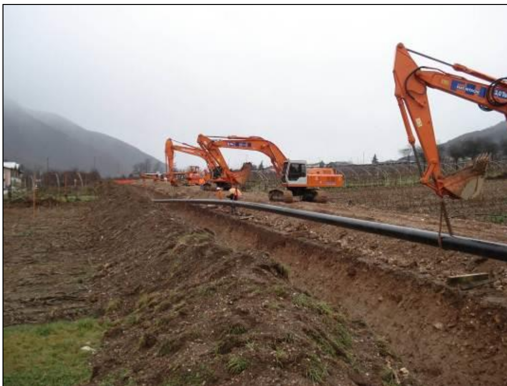
Fig. 3.1.5.8 – Posa della condotta
