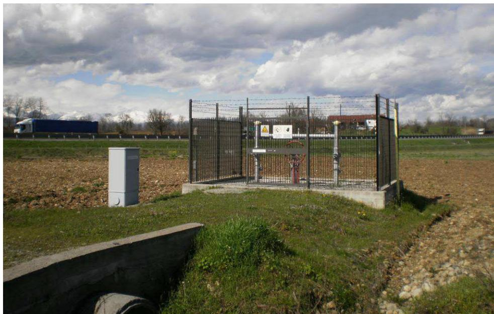
**Fig. II 4.6.10/B – Esempio di impianto tipo HPRS**
