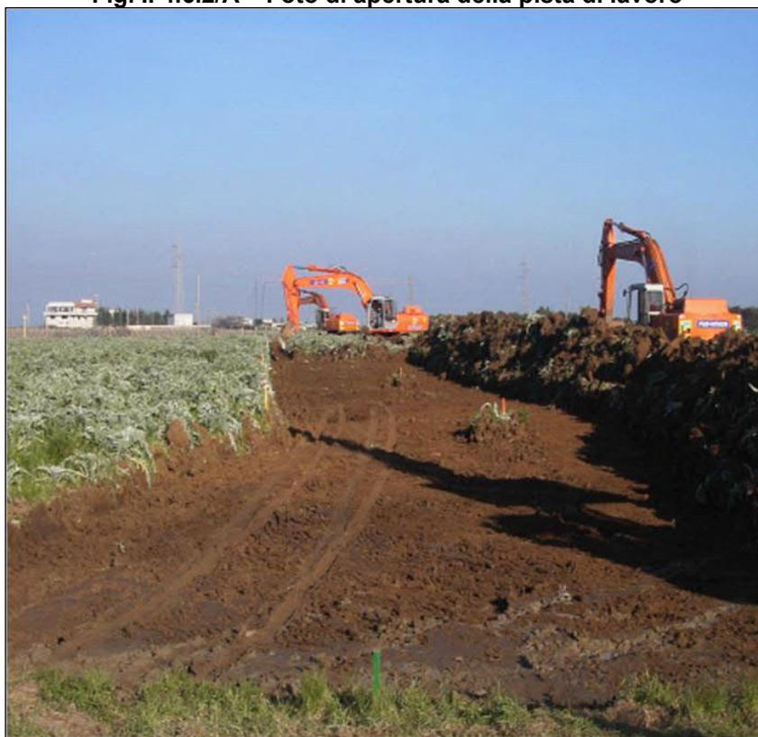
Nelle aree occupate da boschi, vegetazione ripariale e colture arboree (vigneti, frutteti, ecc.), l'apertura della pista di lavoro comporterà il taglio delle piante, da eseguirsi al piede dell'albero secondo la corretta applicazione delle tecniche selvicolturali e la rimozione delle ceppaie.
