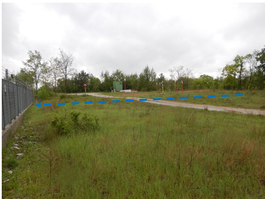
FOTO N.36 - PANORAMICA MET. ESISTENTI E DA DISMETTERE
