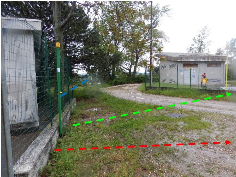
FOTO N.37 - MODIFICHE INTERNE ALL'IMPIANTO N.994 (A DESTRA)
