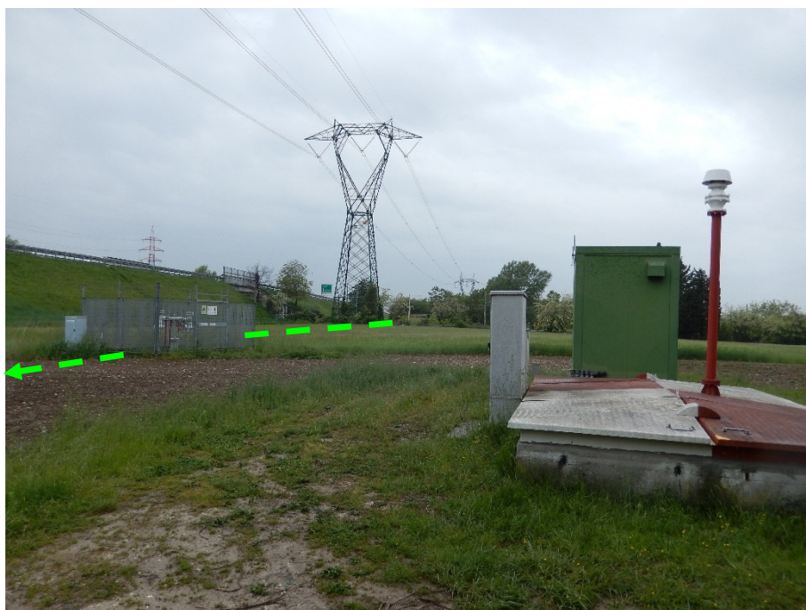
FOTO N.24 - IMPIANTO N.45870.22 SOTTO LINEA ELETTRICA
