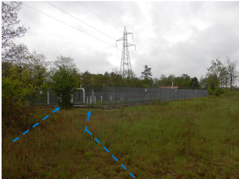
FOTO N.35 - IMPIANTO N.898A DA DISMETTERE
