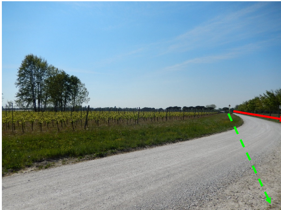
FOTO N.9 - METANODOTTO DA DISMETTERE
