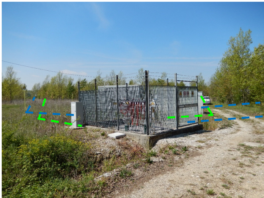
FOTO N.5 - IMPIANTI N. 45870.16 4103631.1 4102044.1 DA DISMETTERE
