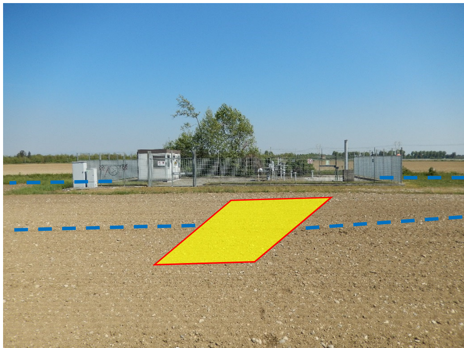
FOTO N.4 - INSTALLAZIONE NUOVO IMPIANTO PIL
