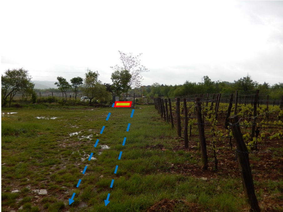
FOTO N.31 - IMPIANTO N. 45870.25 ED INSERIMENTO PIL TC
