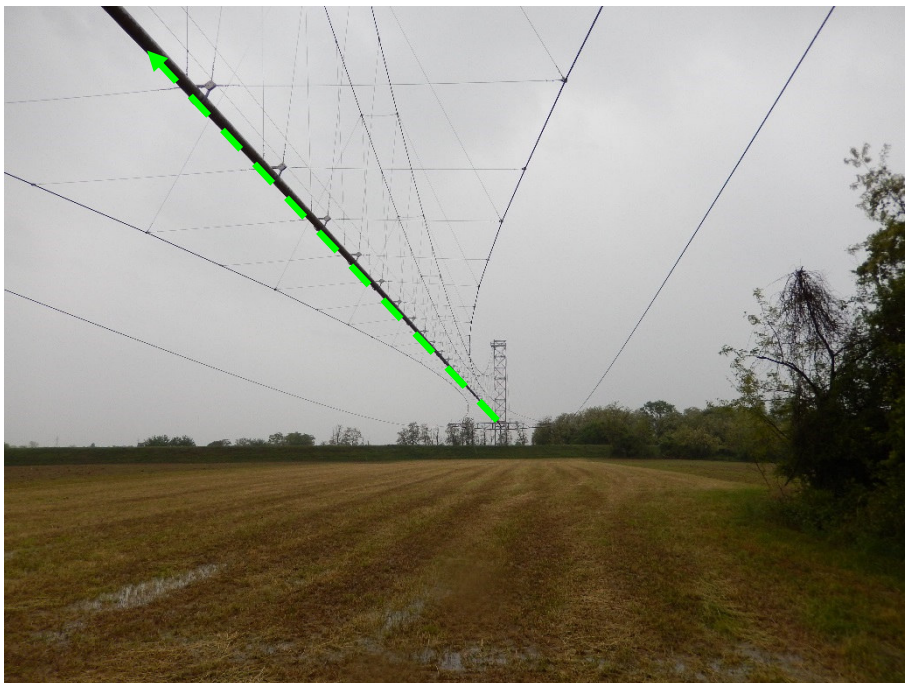
FOTO N.18 - MET. DA DISMETTERE
