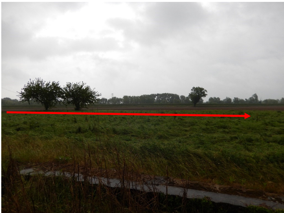
FOTO N.14 - PREPARAZIONE TRENCHLESS PER ATTRAVERSAMENTO FIUME TORRE
