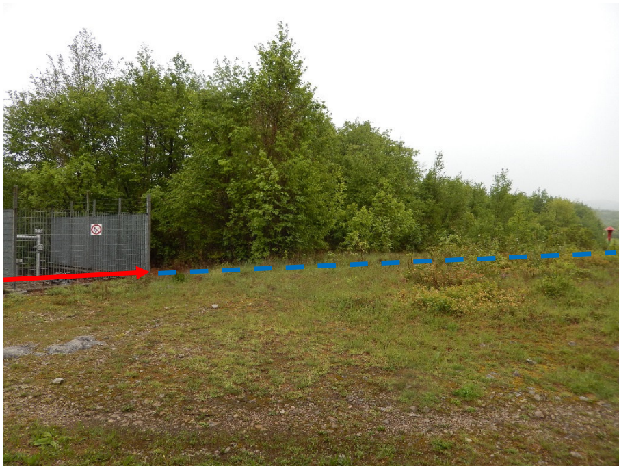
FOTO N.29 - IMPIANTO N. 45870.25 ED INSERIMENTO PIL TC
