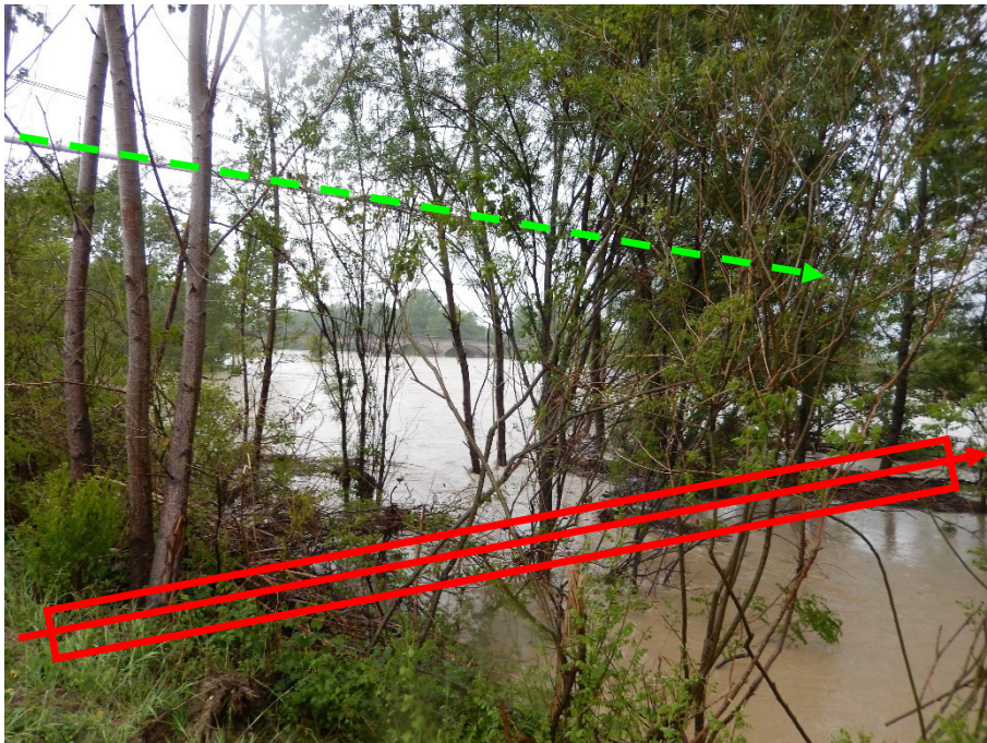
FOTO N.17 - ATTRAVERSAMENTO FIUME TORRE IN TRENCHLESS
