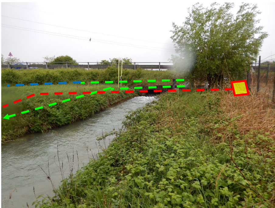
FOTO N.3 - INSTALLAZIONE IMPIANTO PIDI E PERCORRENZA IN ZONA AGRICOLA
