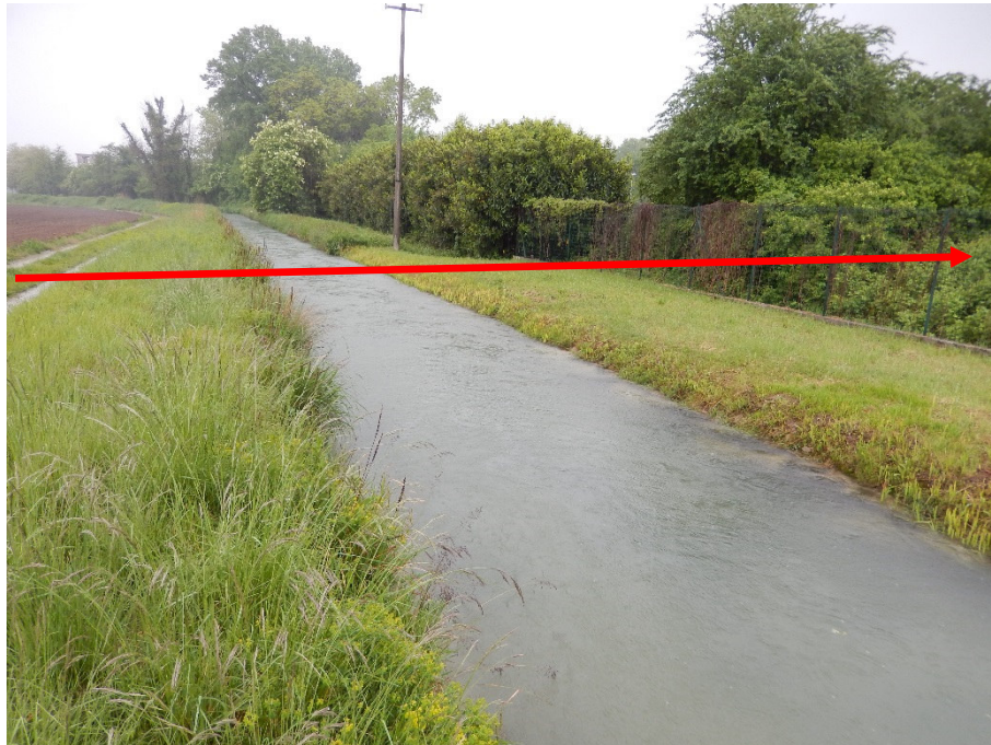
FOTO N.15 - ATTRAVERSAMENTO CANALE SANTA MARIA
