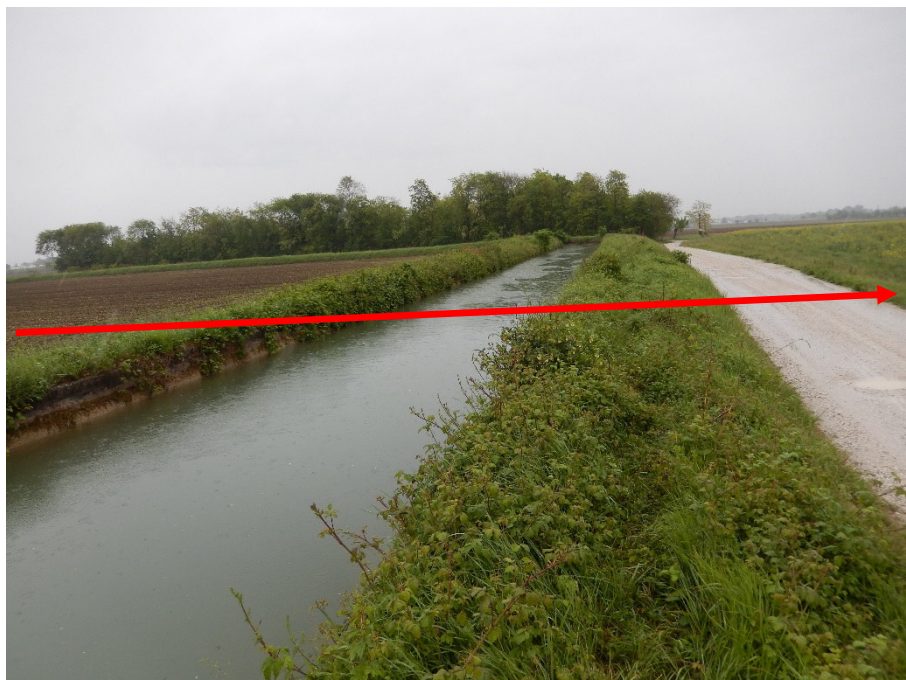
FOTO N.8 - ATTRAVERSAMENTO CANALE SANTA MARIA E STRADA COMUNALE
